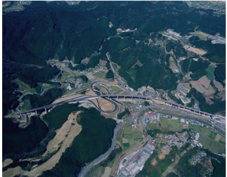
写真 - 2 大洲北只 I C 周辺
