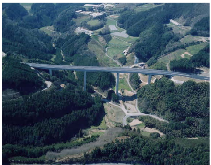
写真 - 4 長谷川橋の全景
