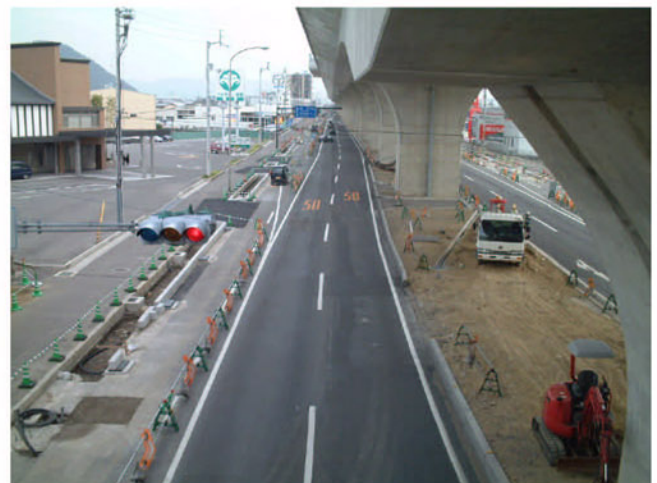
写真－3 勅使交差点より徳島側を望む
