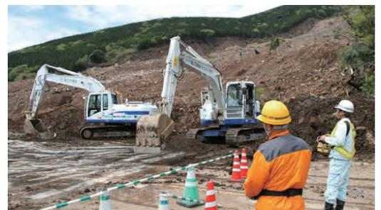
平成28年4月 熊本地震での遠隔操縦
