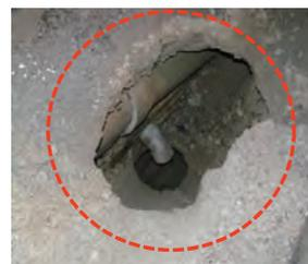
路面下空洞調査で発見した空洞
