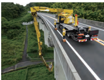
橋梁点検車による点検状況 (国道317号(大島道路)永地高架橋)
