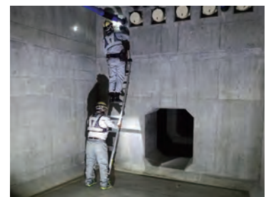
梯子による点検状況 (国道33号(三坂道路)つづら川第4橋)
