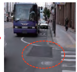
補修後の状況
