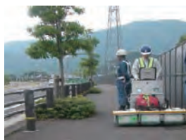
歩道部調査で使用する探査装置
