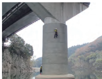
ロープによる点検状況 (国道56号(大洲道路)大洲大橋)
