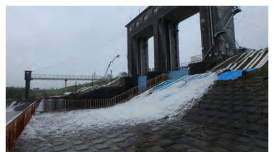
令和元年10月 台風19号による 被災現場での排水作業(千葉県印旛郡)
