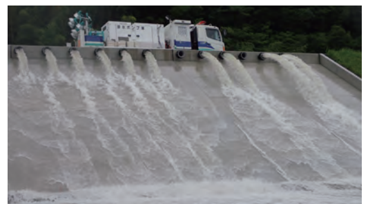
平成30年7月豪雨での排水ポンプ車による 内水排除活動(高知県土佐市)
