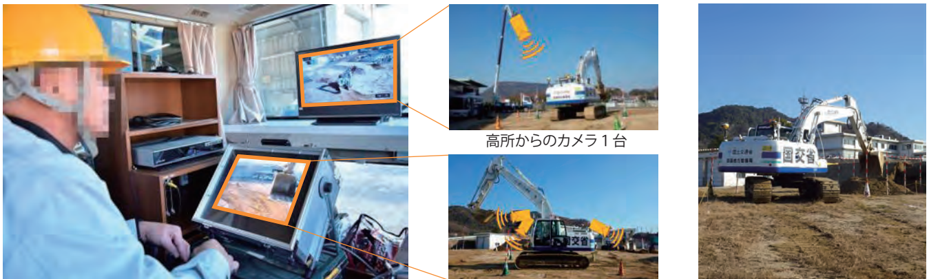
遠隔操縦式バックホウの操作訓練状況
