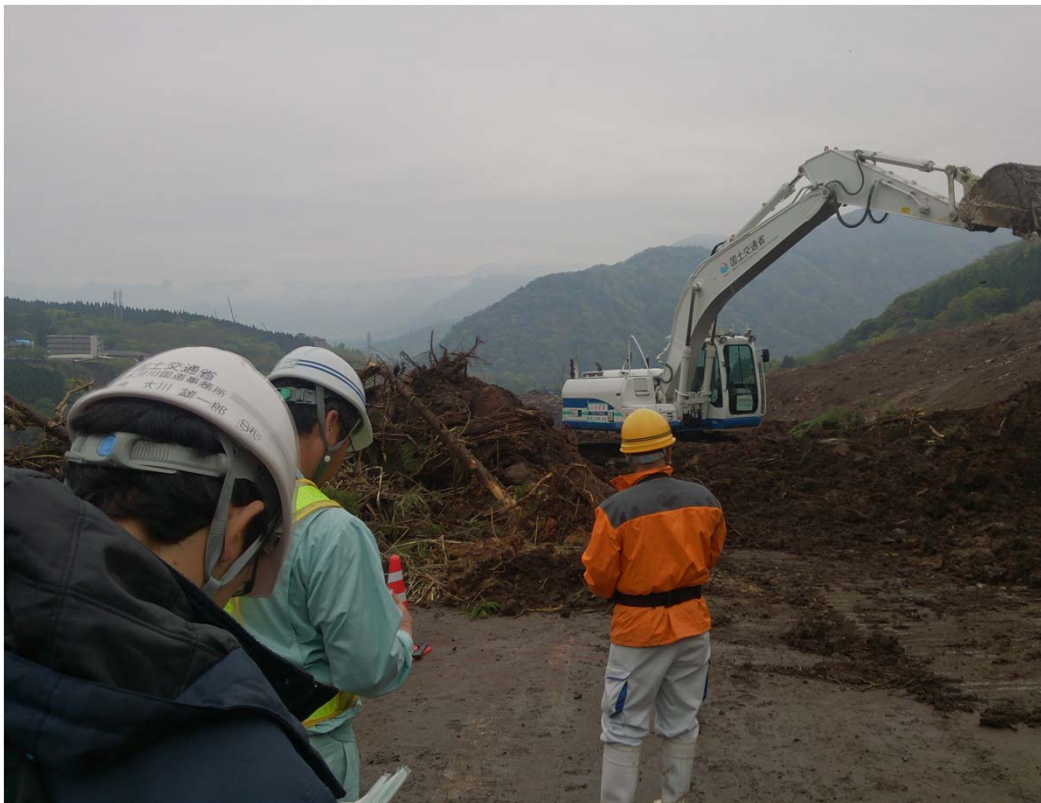
南阿蘇での掘削作業状況（コーンから奥は侵入禁止区域）
