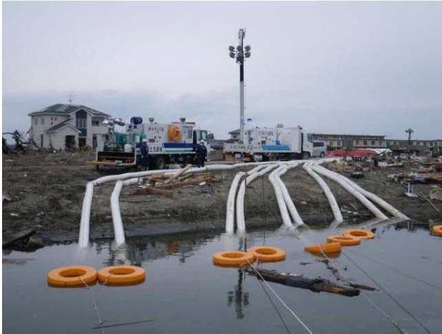
東日本大震災で活躍する排水ポンプ車
