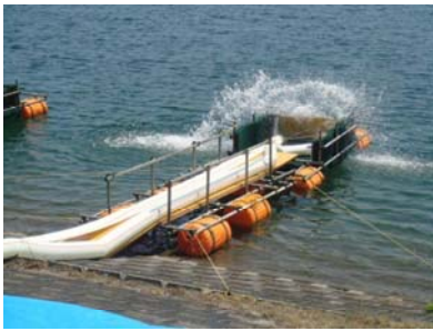
ポンプにより排水中
