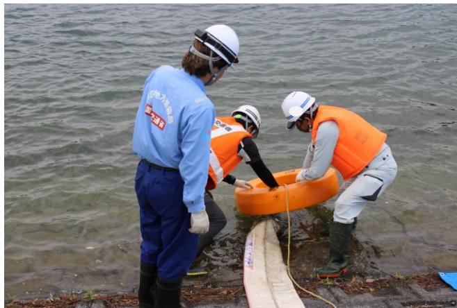
排水ポンプ投入
