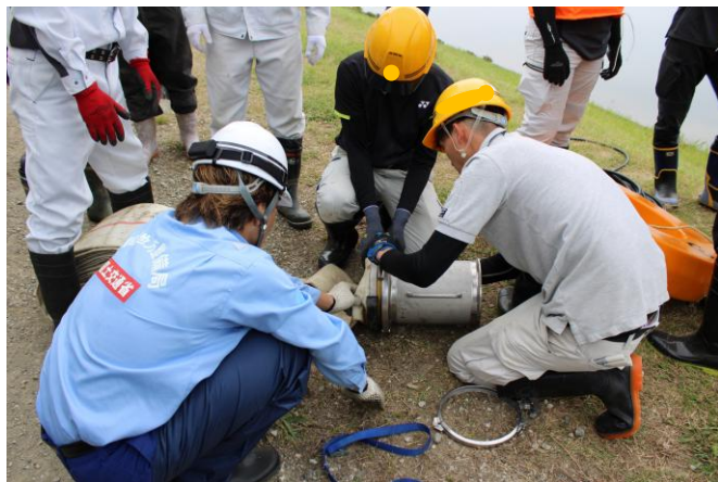
排水ホース接続状況
