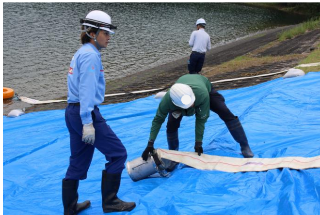
排水ホース設置
