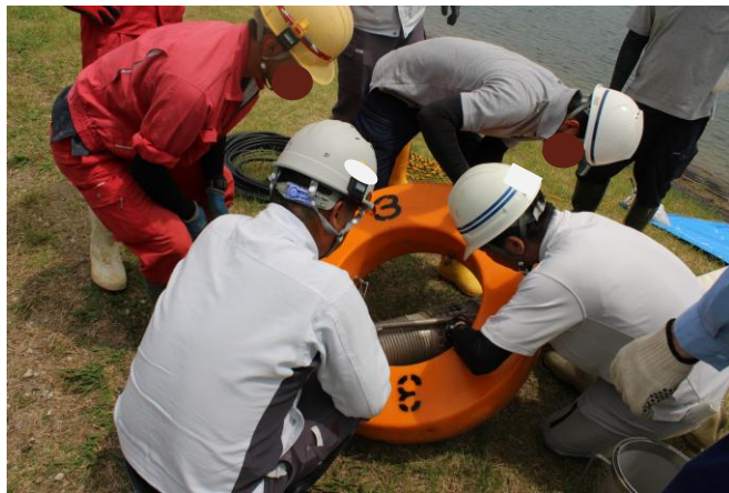
排水ポンプにフロートを取付
