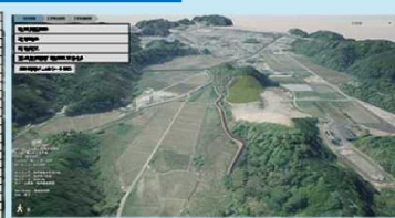
工事施工段階
