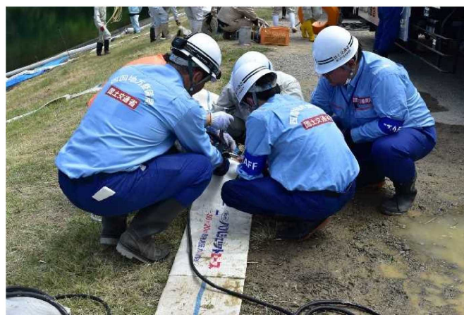
排水ホース接続状況
