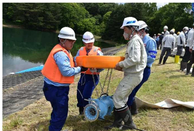
排水ポンプにフロートを取付
