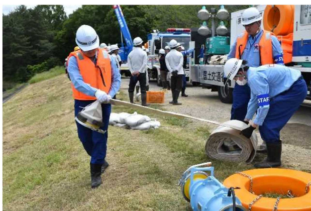
排水ホース設置
