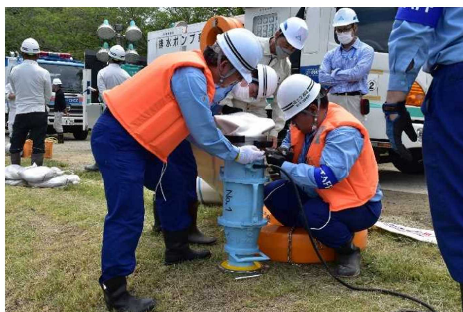
排水ポンプに排水ホースを接続
