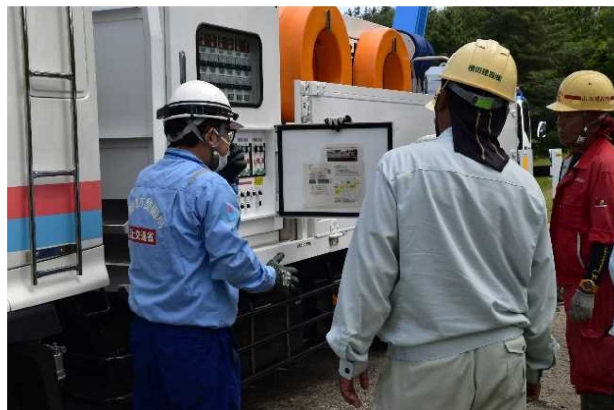
排水ポンプ起動
