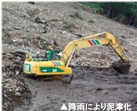
▲足場が悪く重機が沈み込む
