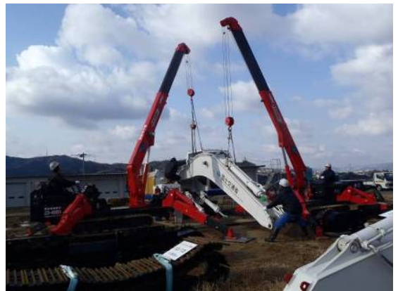
「⑥パーツ」組立状況写真
