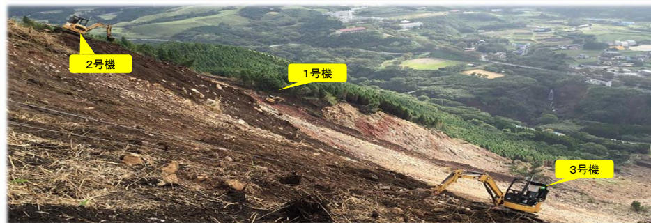
▲斜面頭部では3台の高所法面掘削機が稼働中
