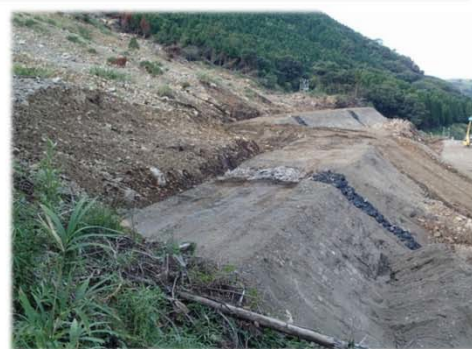
▲8月末、土留盛土の上段が完成
