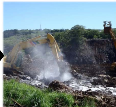
▲土砂を改良しながら施工
