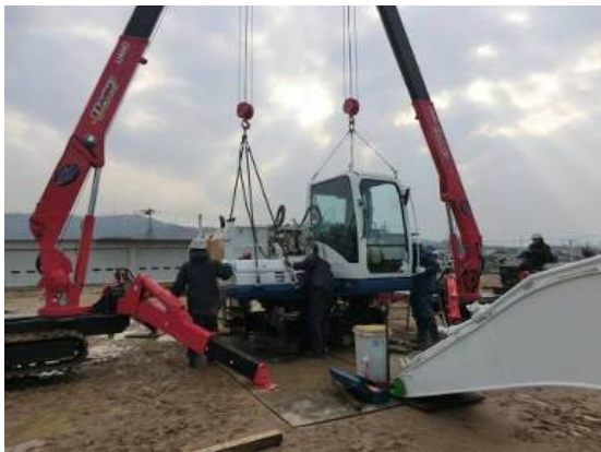
「⑤パーツ」組立状況写真
