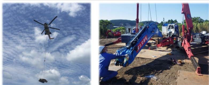
▲分解した重機をヘリで空輸し、頭部で組立
