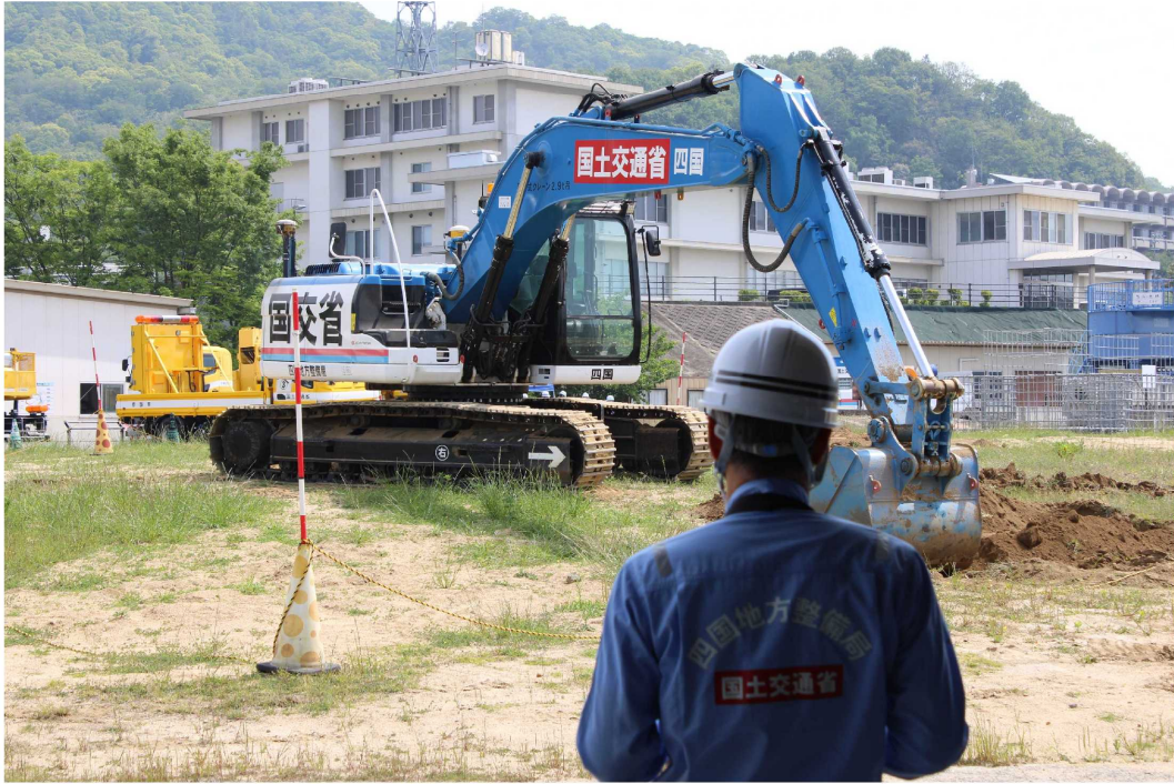
バックホウの遠隔操縦訓練
