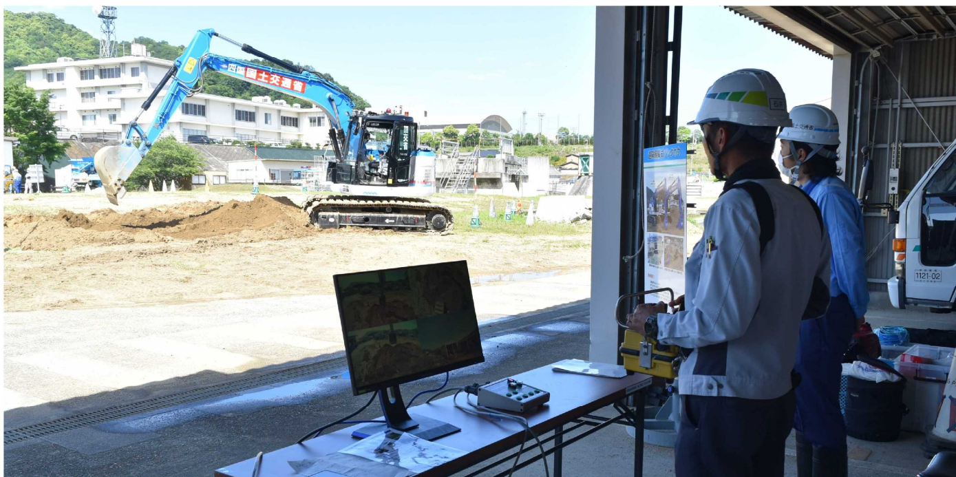
バックホウの遠隔操縦訓練
