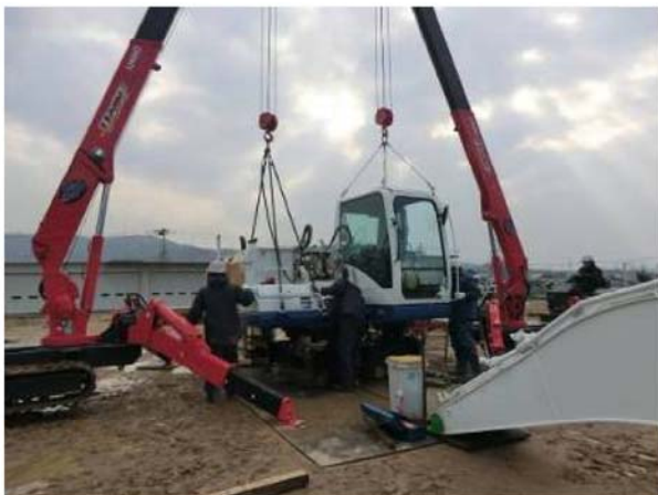
「⑤パーツ」組立状況写真
