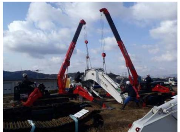
「⑥パーツ」組立状況写真
