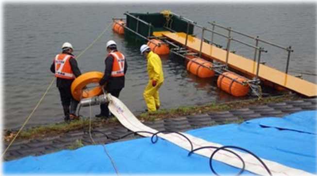
排水ポンプ投入
