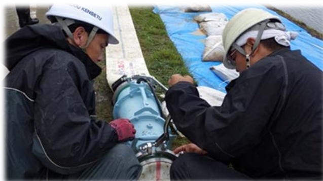
ポンプに排水ホースを接続
