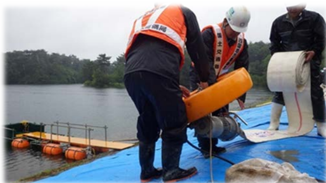
ポンプにフロートを取付
