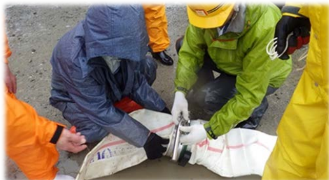
ホース接続状況
