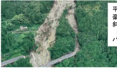
平成30年7月7日未明、梅雨前線の活発化による豪雨のため、大豊町の高知自動車道で大規模な斜面崩壊が発生し、上り線の立川橋が流出。
