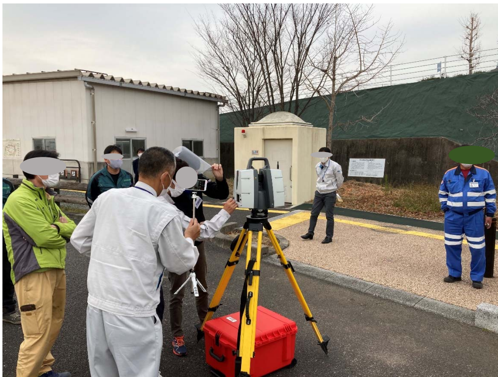
地上型レーザースキャナーを用いた測量と出来形管理（実演）
