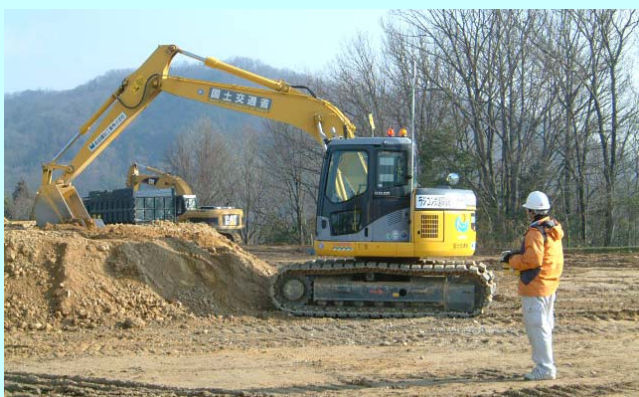
目視でのラジコンによる操作練習の様子
