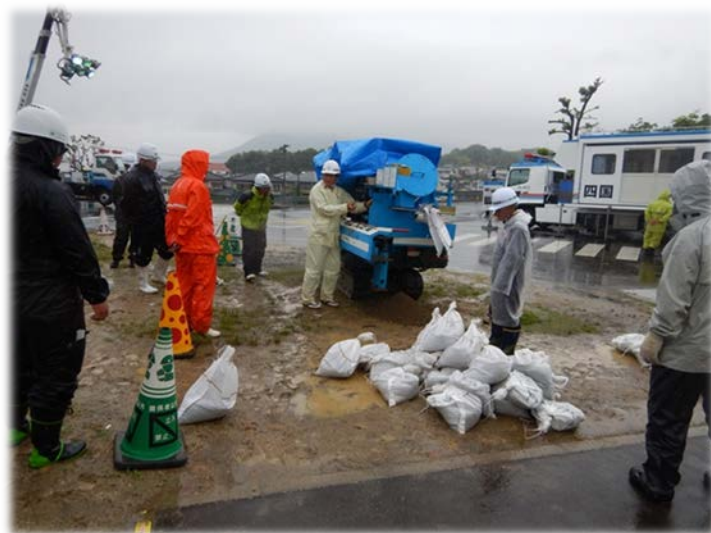
土のう造成機による土のう作製訓練
