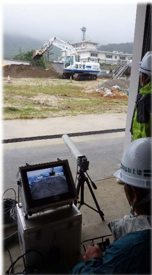
ラジコンバックホウの 遠隔操縦訓練
