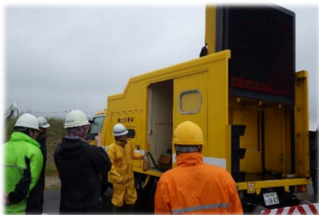
標識車の設営訓練
