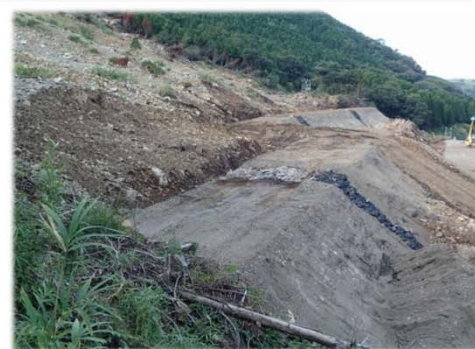
▲8月末、土留盛土の上段が完成
