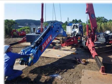
▲分解した重機をヘリで空輸し、頭部で組立
