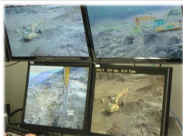
▲遠隔操作で14台の無人化機械が稼働
