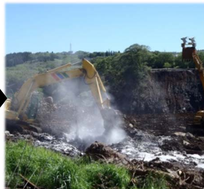
▲土砂を改良しながら施工
