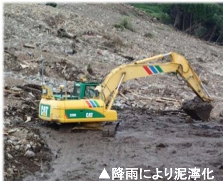
▲足場が悪く重機が沈み込む
