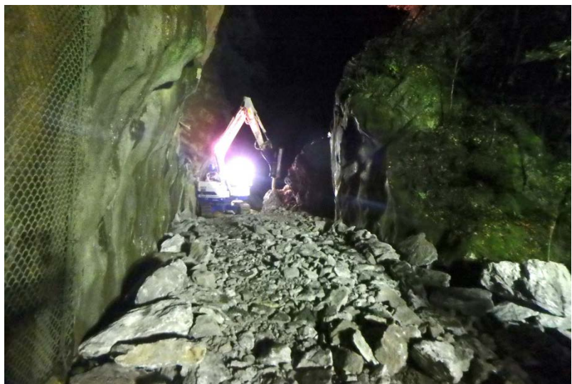
遠隔操縦油圧ショベルによる作業状況
