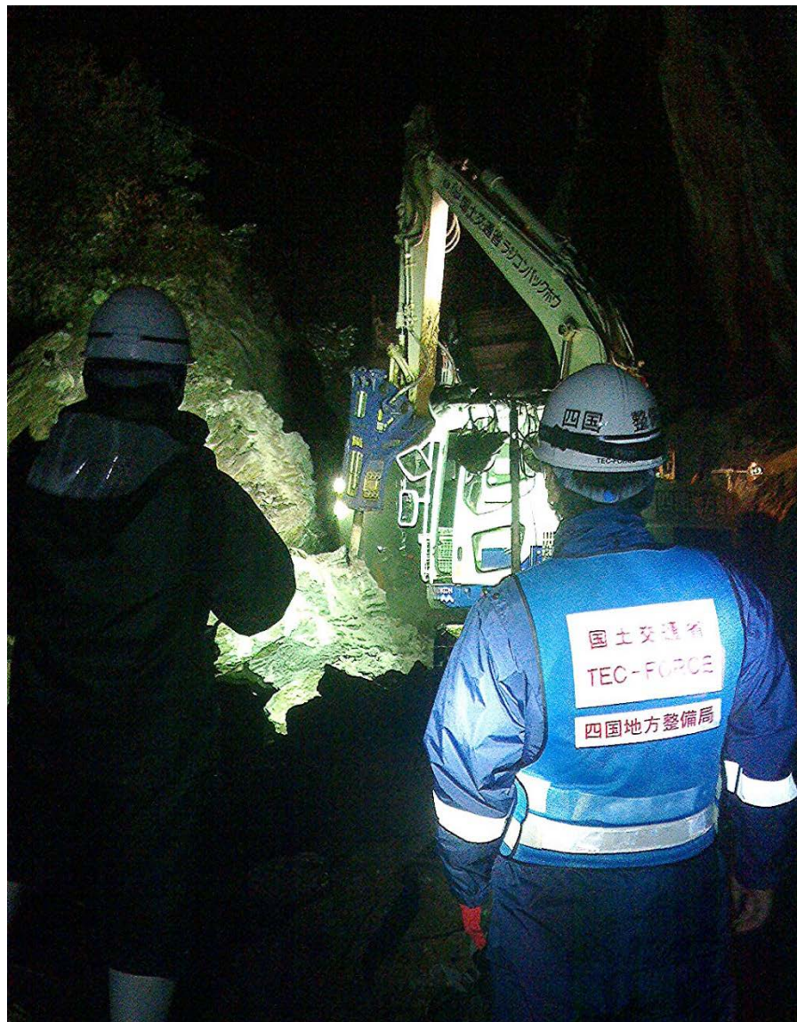
二次災害を防止する遠隔操縦での復旧作業
