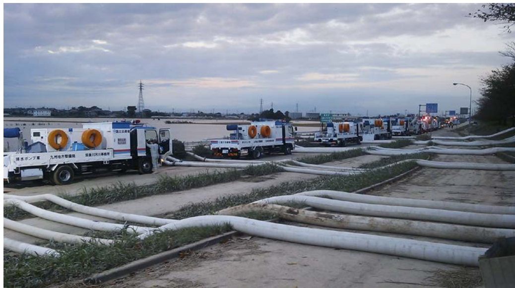
鬼怒川破堤により浸水した茨城県常総市での排水作業状況①
