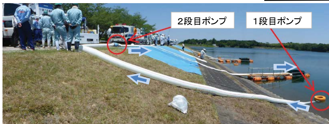
写真-9 排水ポンプ車（高揚程型）の設営状況
