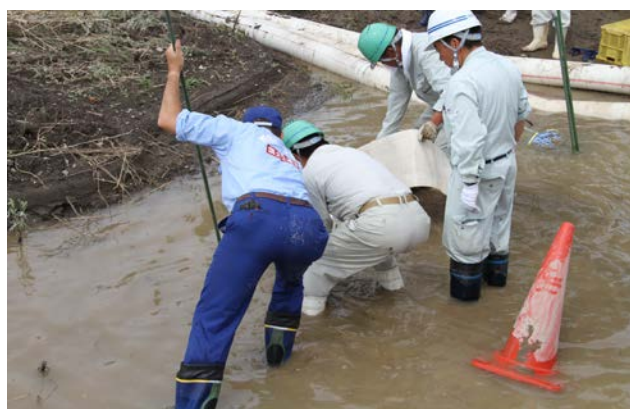
排水ポンプの設営作業状況
