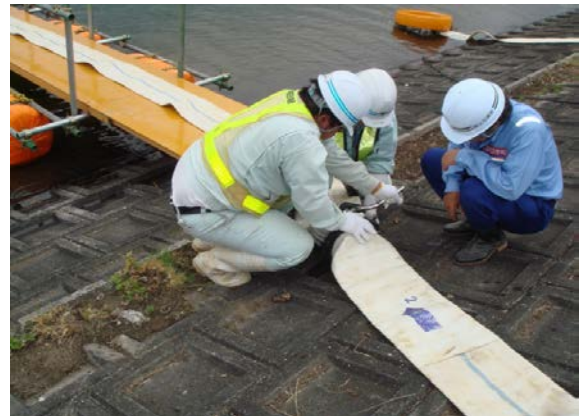
写真-4 排水ホースの連結
