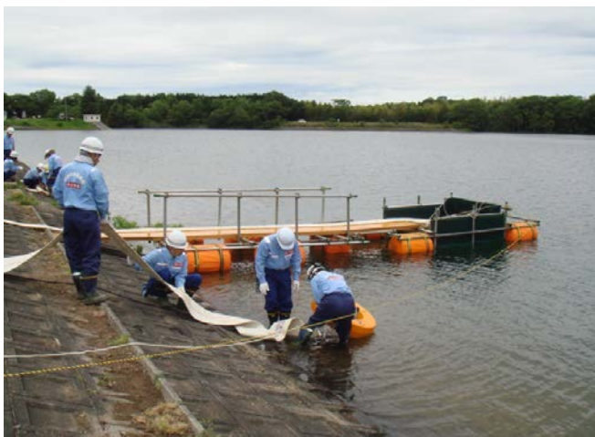
写真-5 ポンプを投入
