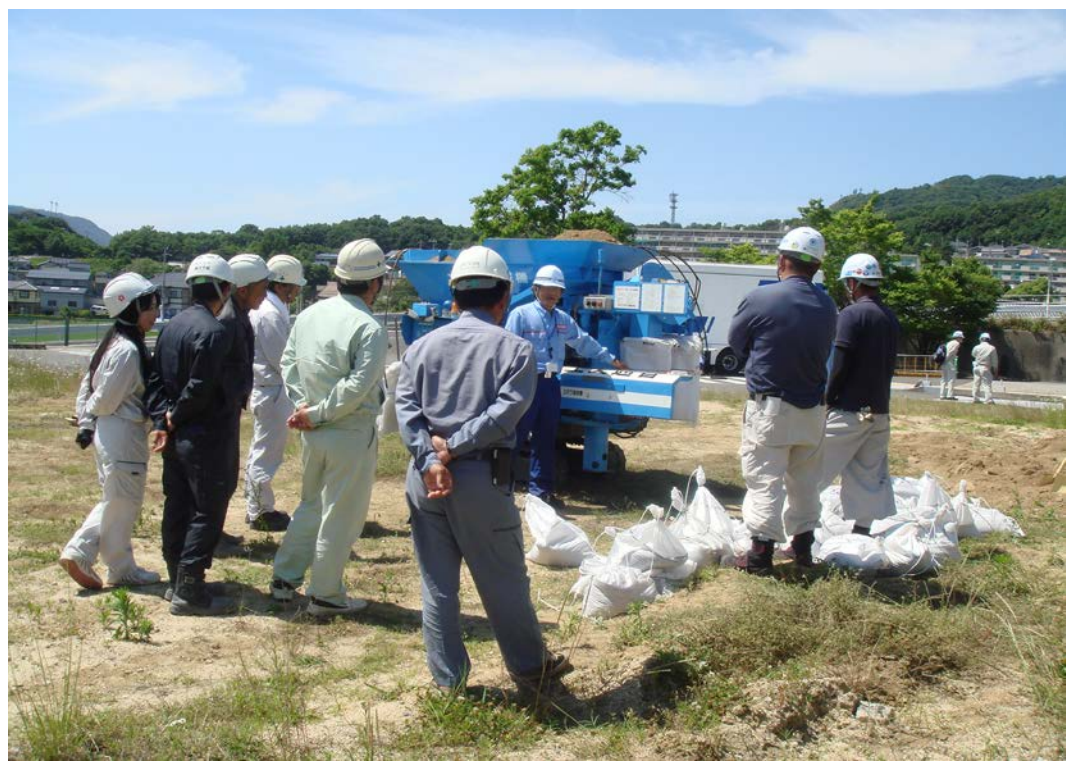
土のう造成機による土のう作り訓練
