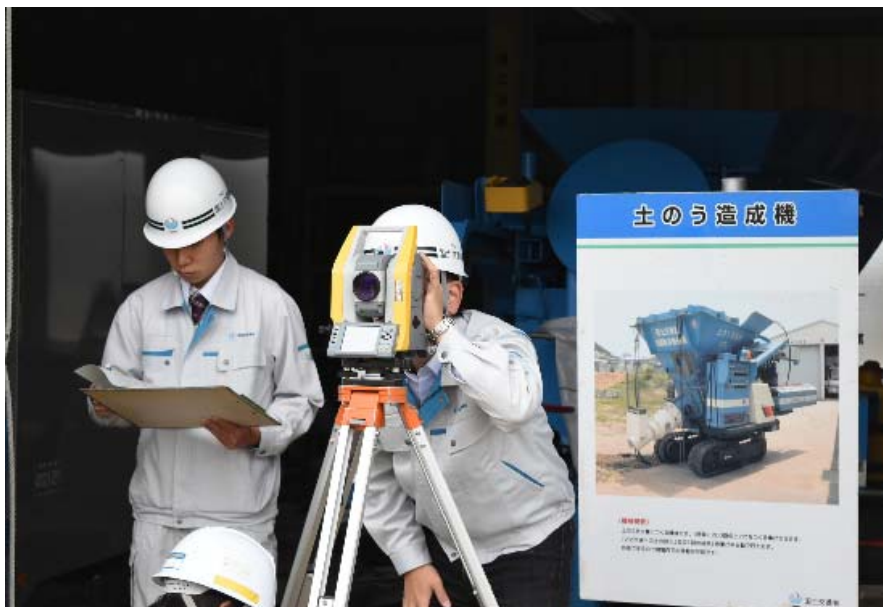
TS測量状況
