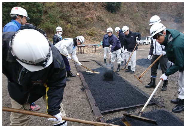
アスファルト舗装体験（敷均し）
