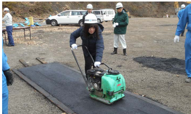
プレートコンパクターでの転圧作業
