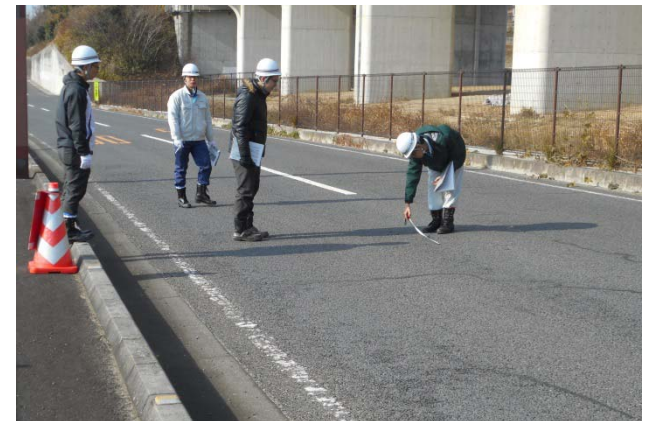
現道での舗装点検実習
