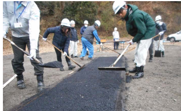
アスファルト敷均し（レーキ）体験
