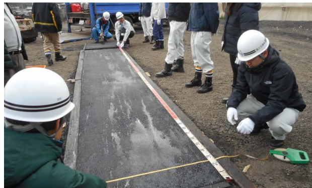
アスファルト舗装面の出来形確認
