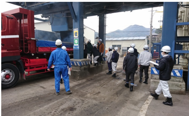
サイロからのアスファルト積込状況
