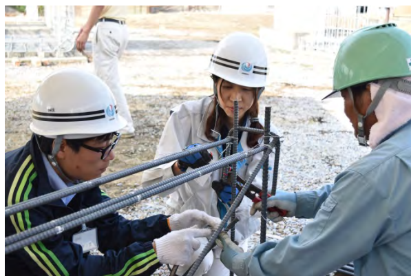
鉄筋の組立状況(A班)
