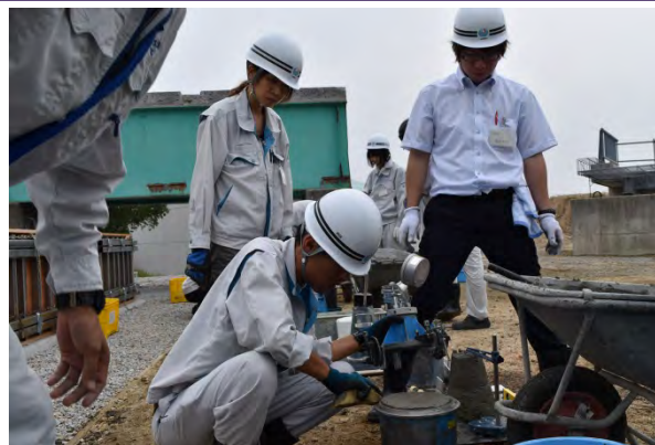
生コンクリートの受入時検査(空気量)
