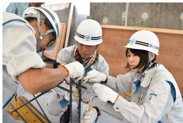
鉄筋の組立状況(B班)
