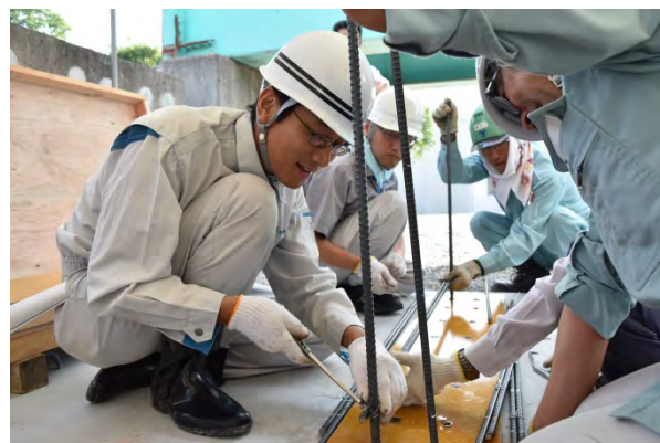
鉄筋の組立状況(C班)
