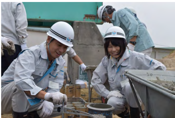
生コンクリート受入時検査の実施
