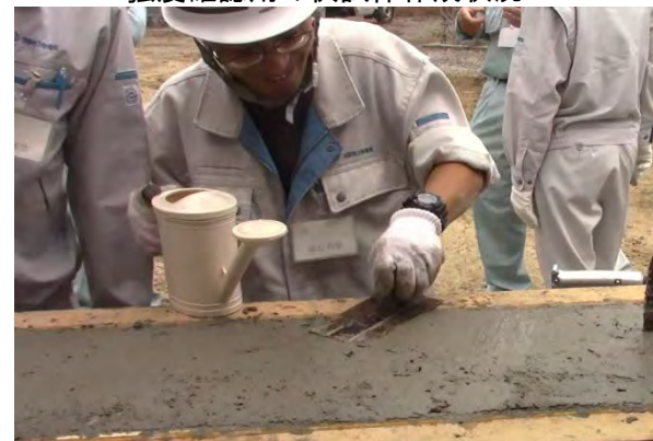
上端のコテ仕上げ状況
