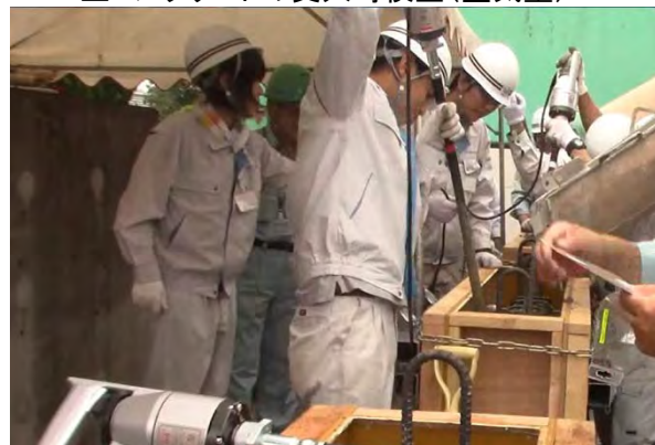
コンクリートの打設状況(B班)
