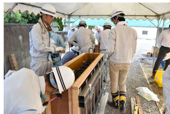
型枠の組立状況
