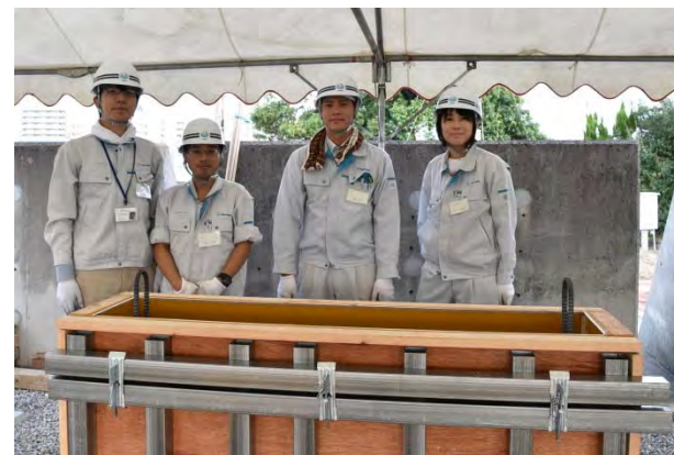
B班：型枠組立完了時点
