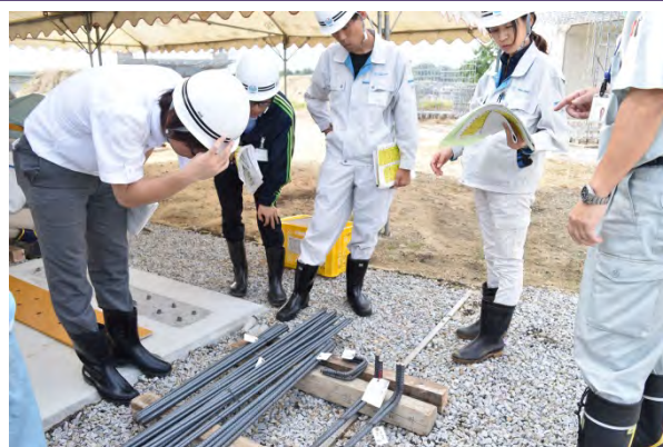
材料検査の説明(主鉄筋・配力鉄筋)
