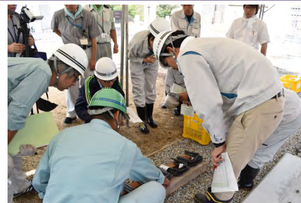
材料検査の説明(鉄筋)
