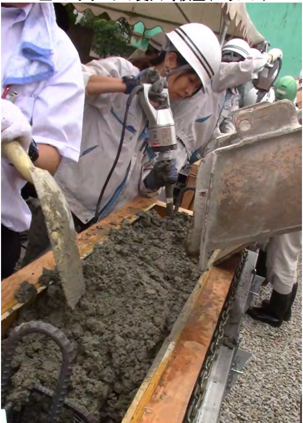
コンクリートの打設状況(A班)
