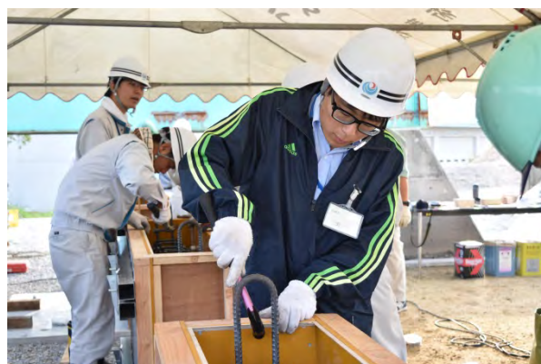
型枠の組立状況
