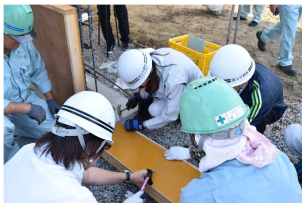
型枠の組立状況(面木の取り付け)
