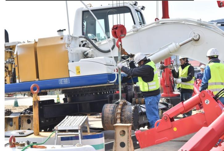
【組立2/2】 小型クローラクレーンにて各パーツを組立(約3日間 作業時間 9:00~17:00)
