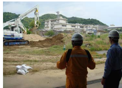
遠隔操縦式バックホウ操作訓練
