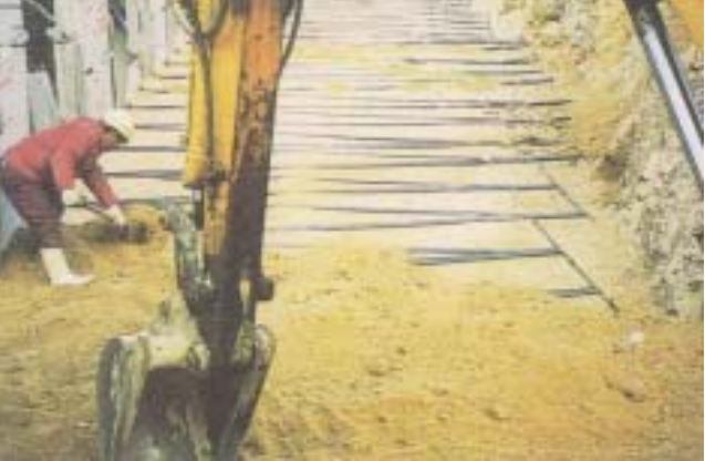
土の巻き出し状況
