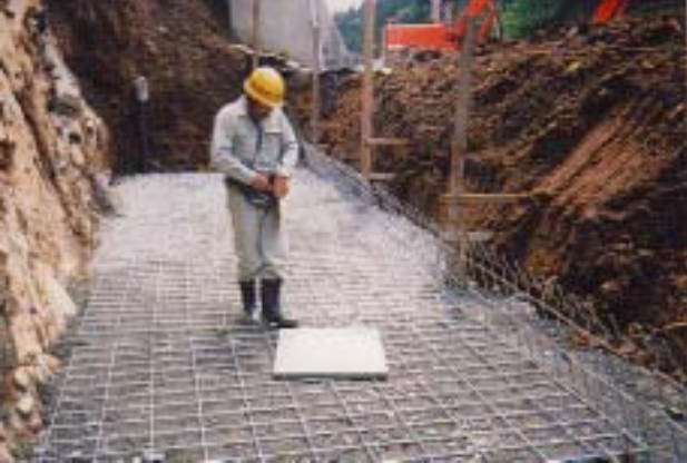
ワイヤーマット設置状況
