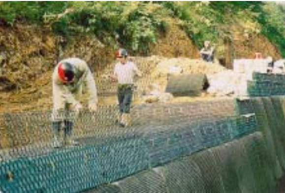
前面壁組立状況
