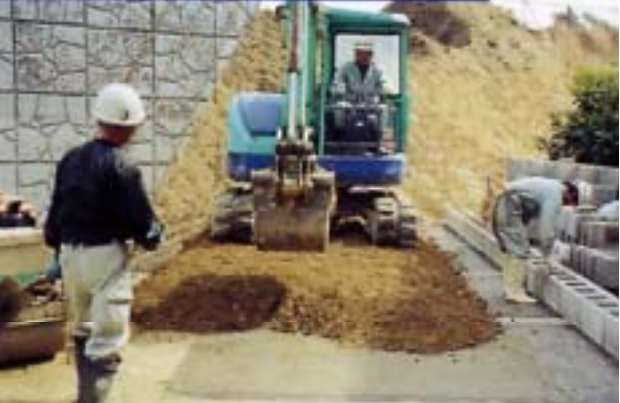
まき出し転圧状況
