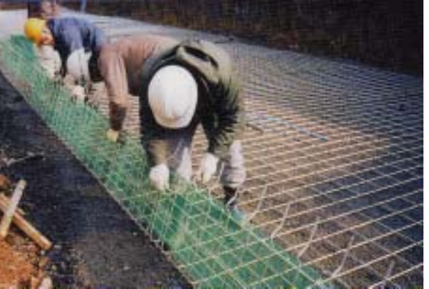
ジオメッシュ設置状況
