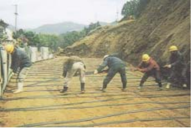
パラウェブの敷設状況
