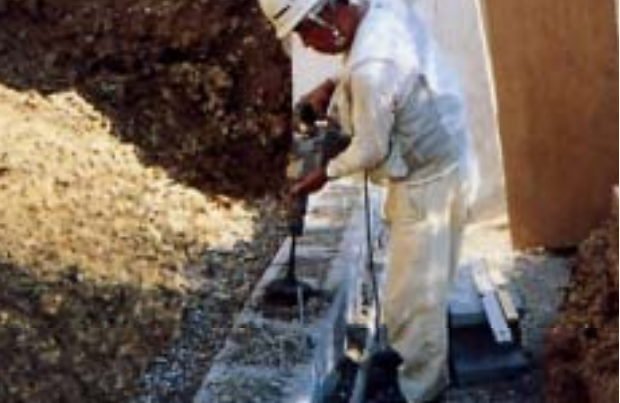
胴込碎石施工状況
