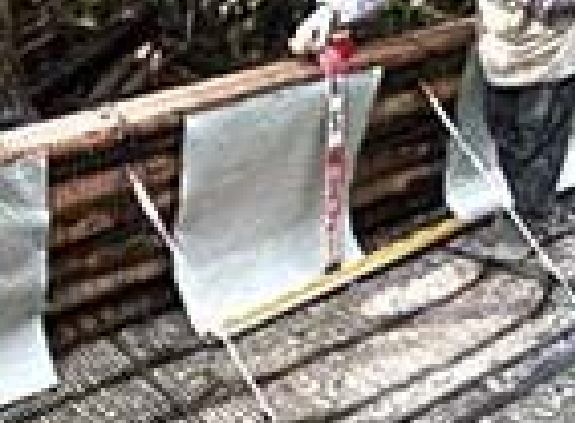
ジオグリッド敷設状況
