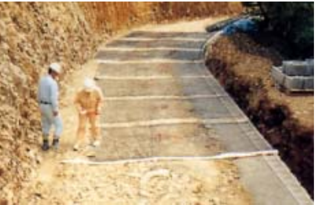
補強材敷設状況
