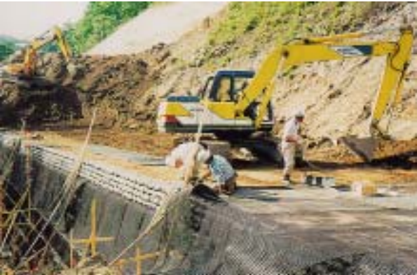
ジオグリッド設置状況
