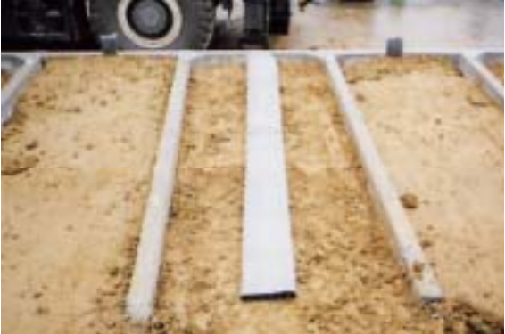
排水マット敷設状況
