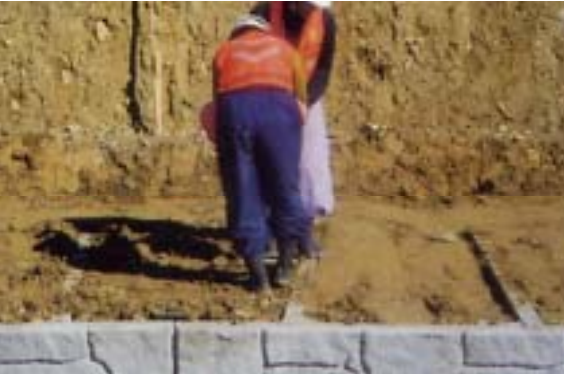
胴込転圧状況
