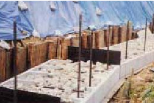
ガラ等敷設状況
