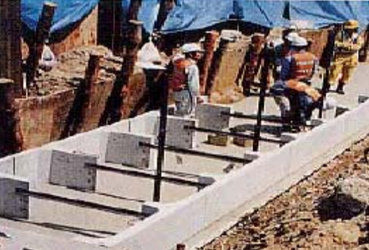
ブロック組立て状況
