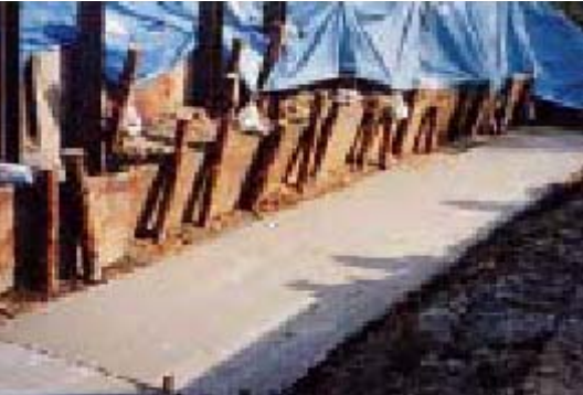
基礎施工状況
