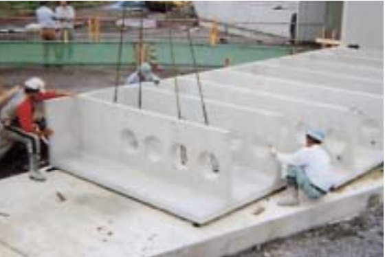
ブロック据付状況
