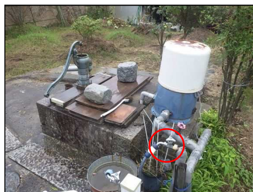
図-3.8 井戸水の給水栓の例
