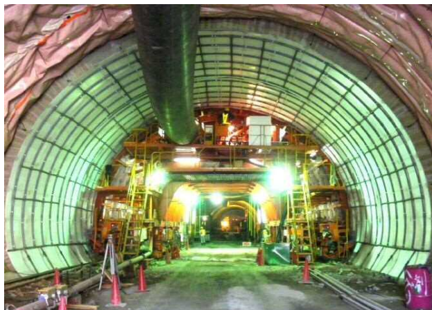
写真 5-4 パネル養生の事例 20)
