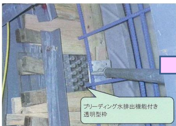
写真-19 透明型枠の事例
