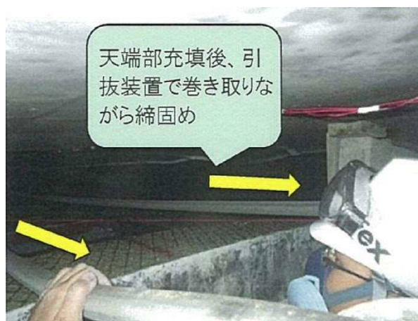
写真-7 天端引抜きバイブレーターの事例 48) に加筆
