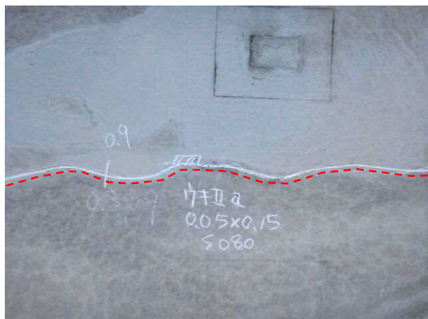
写真 2-17 色むら・打重ね線に沿って発生したひび割れ
