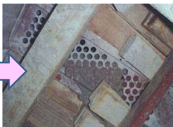
写真-18 ブリーディング水の排出状況
