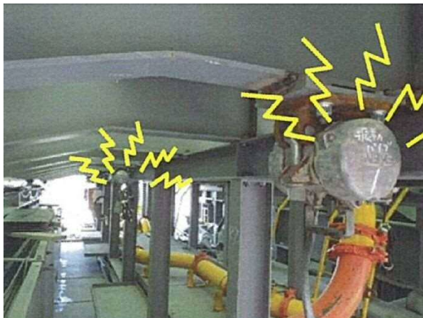
写真-9 型枠振動バイブレーター 46)に加筆
