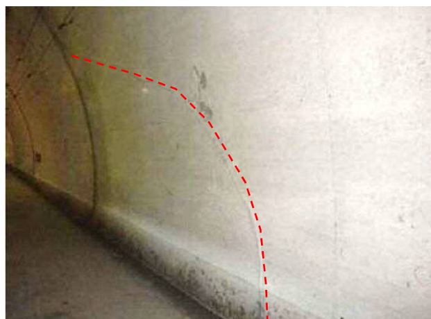
写真 2-18 打重ね線に沿って発生したひび割れ
