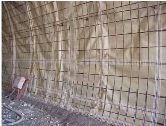
写真-29 トンネル覆工コンクリートへの施工事例 35)
