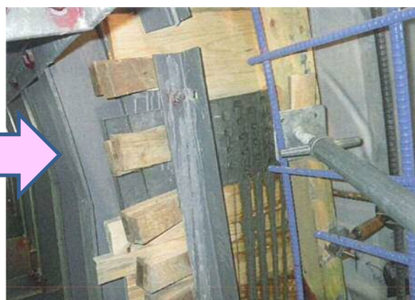
写真-20 ブリーディング水の排出状況
