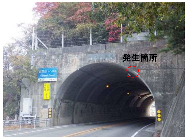
写真 2-28 坑口部の剥落（補修工の劣化）
