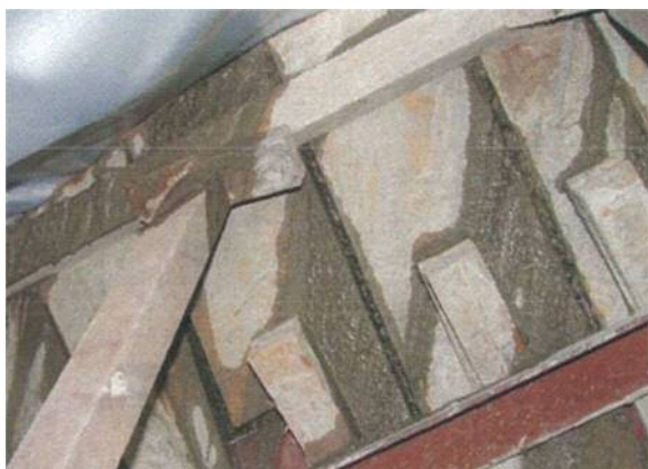
写真-15 木製型枠の隙間を空けた事例
