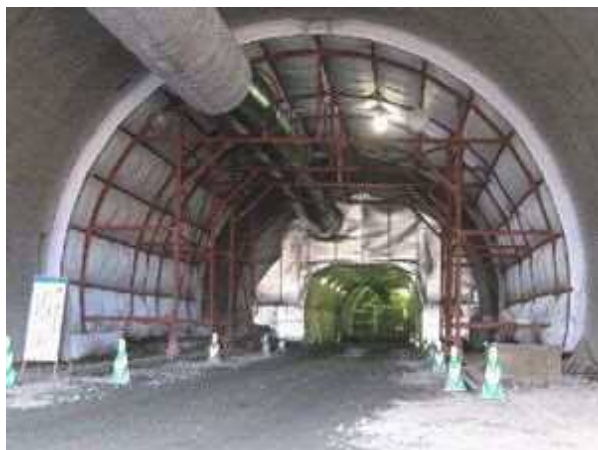
写真 5-1 保湿養生（バルーン養生）の事例 18)
