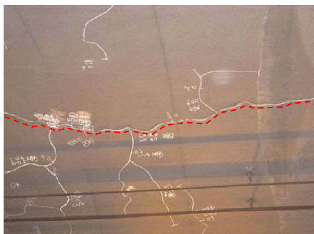
写真 2-20 アーチ部の縦断方向ひび割れから発生した横断方向のひび割れ
