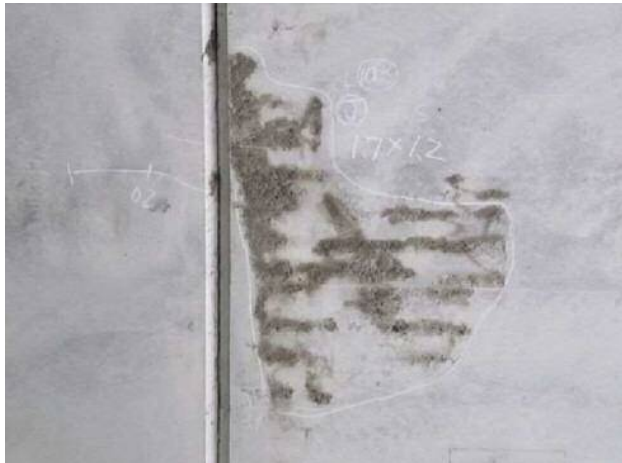
写真 2-21 表面のあばた（表面のはく離）
