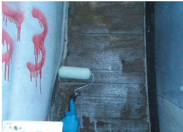
写真-23 既設目地部への付着低減剤の塗布 32)
