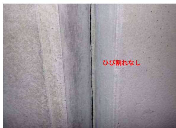
写真-25 付着低減剤の塗布ありの場合 32) に加筆
