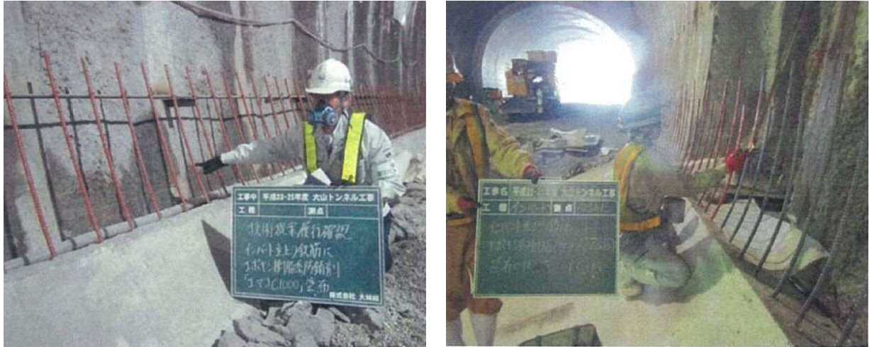
写真-30 トンネルにおける補強鉄筋への防錆塗装の施工事例
