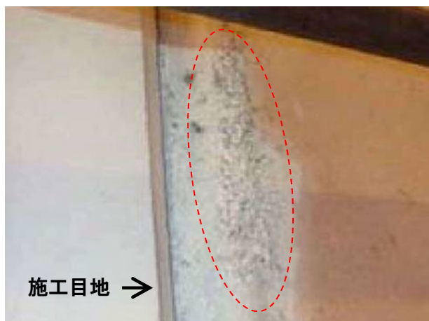
写真 2-24 施工目地の不良（豆板）
