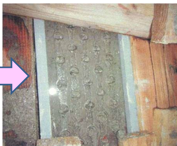
写真-4 透明妻型枠の状況（充填後）
