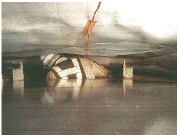
天端部の打設状況
