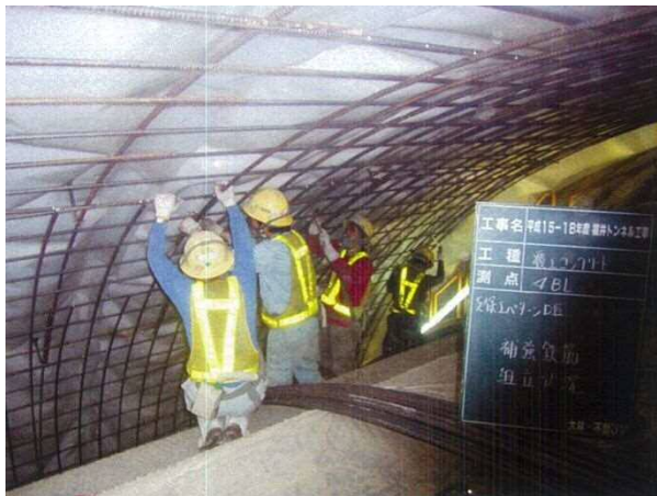
写真 2-32 覆工コンクリートの補強鉄筋の事例
