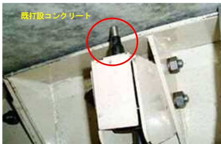
写真-1 押上げ防止センサー 23) に加筆
