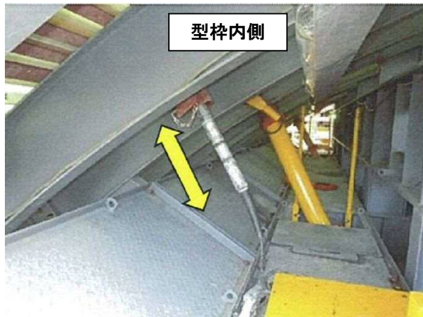
写真-8 伸縮式バイブレーター 45)に加筆
