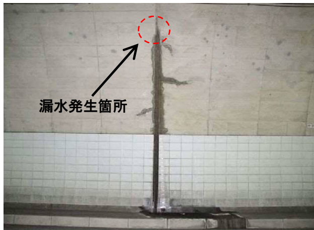
写真 2-25 施工目地からの漏水
