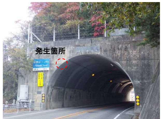
写真 2-27 坑口部のはく離（補修工の劣化）
