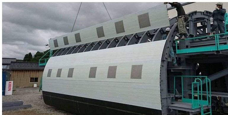
写真-14 セントルへの取付け状況 44)
