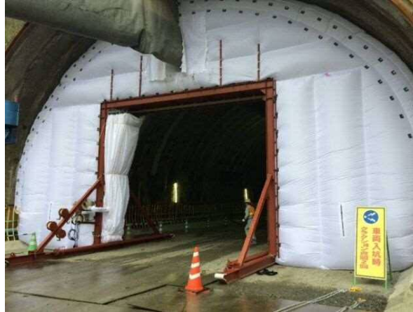
写真 5-6 隔壁（バルーン隔壁）の事例 22)
