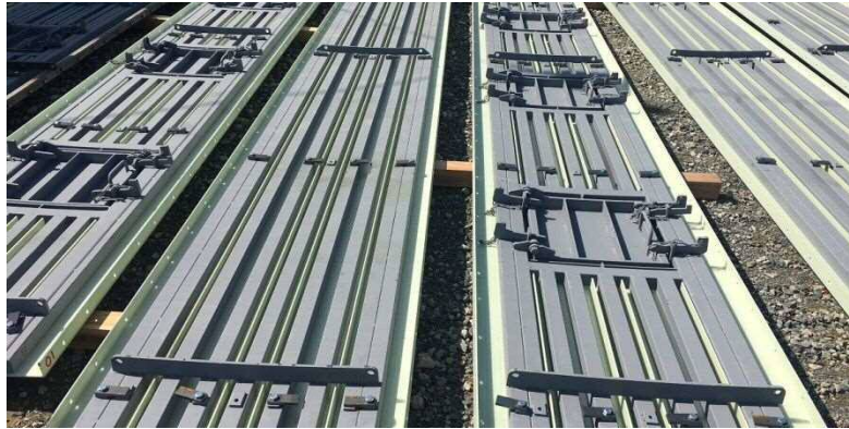
写真-13 F R P 製型枠 44)
