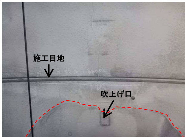
写真 2-9 吹上げ口から発生した色むら・打重ね線
