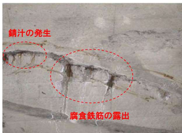
写真 2-26 腐食鉄筋の露出
