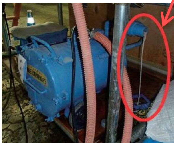
写真-21 ブリーディング水の排出状況 13)
