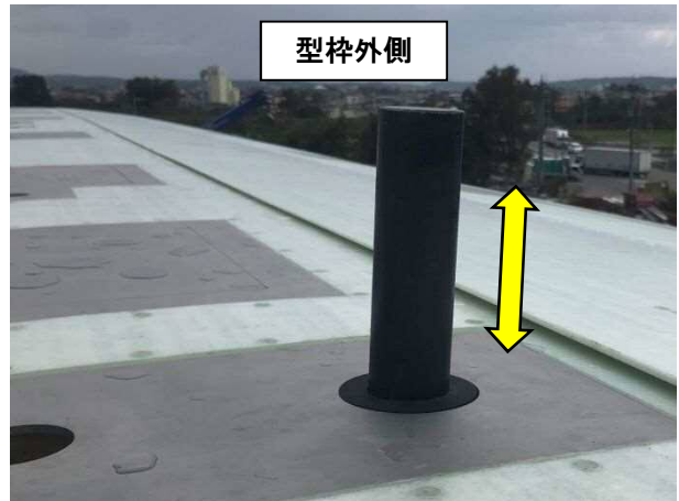
写真-8 伸縮式バイブレーター 45)に加筆
