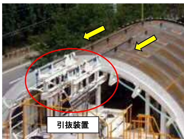
写真-7 天端引抜きバイブレーターの事例 48) に加筆
