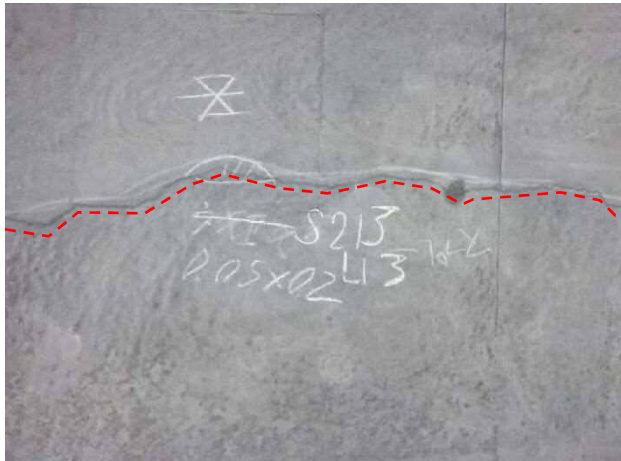
写真 2-16 色むら・打重ね線に沿って発生したひび割れ
