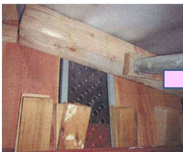
写真-3 透明妻型枠の状況（充填前）
