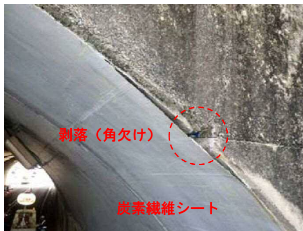
写真 2-28 坑口部の剥落（補修工の劣化）
