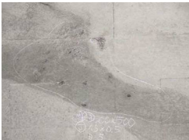
写真 2-22 表面の気泡
