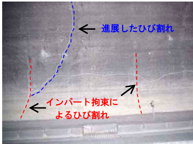
写真 2-12 インバート拘束による横断方向のひび割れ
