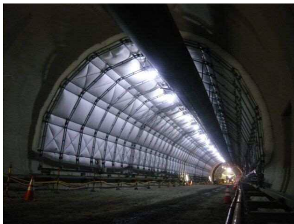
写真 5-3 給水養生（アクアカーテン養生）の事例 19)
