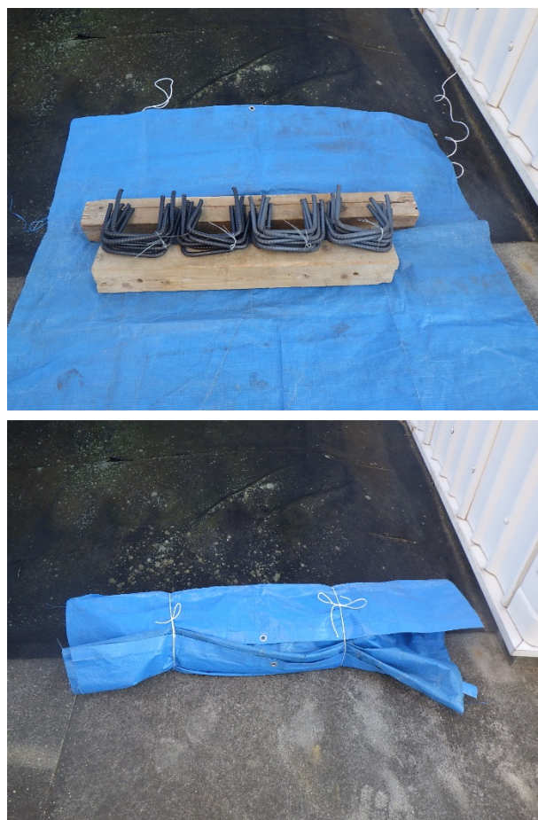
写真 3.1 鉄筋の保管例
