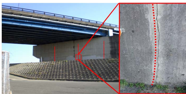
写真 10.1 外部拘束による温度ひび割れ事例
