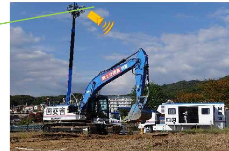
照明車カメラによる俯瞰映像
