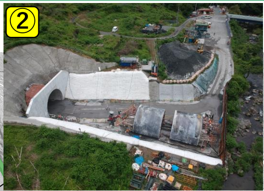
トンネル吐口部の状況
