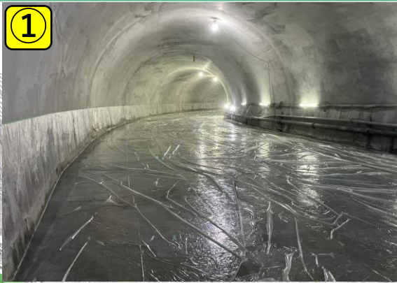
トンネル内作業状況
