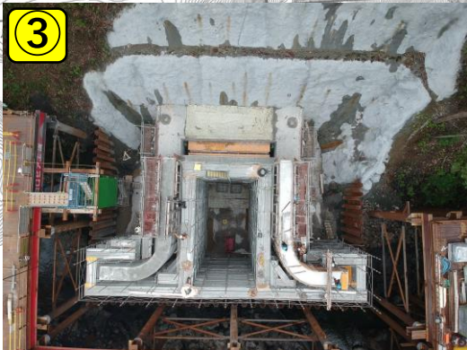
呑口作業状況
