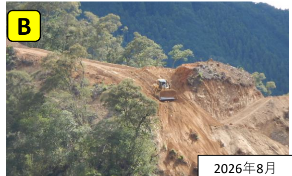
左岸を掘削しています
