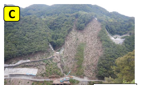
仮設構台を撤去しています
