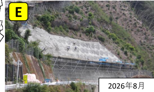
地すべり対策をしています
