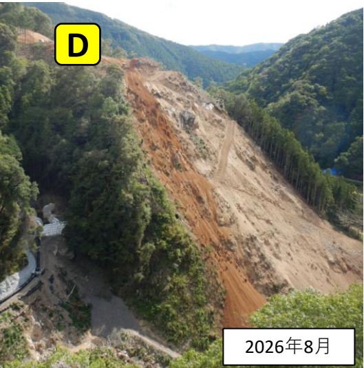
左岸を掘削しています
