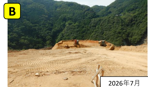
左岸を掘削しています
