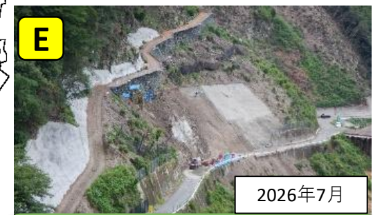
地すべり対策をしています
