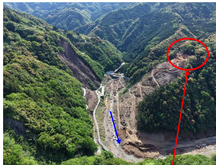
基礎掘削(全景)
