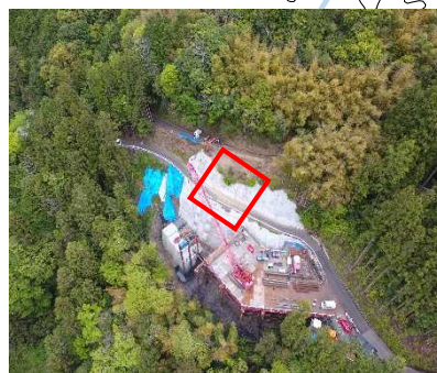
新入船橋A1橋台
