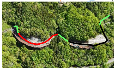
月野尾工事用道路
