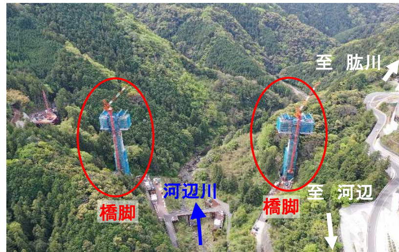
⑤下嵯峨谷付替市道(令和8年4月) 〈新入船橋〉
