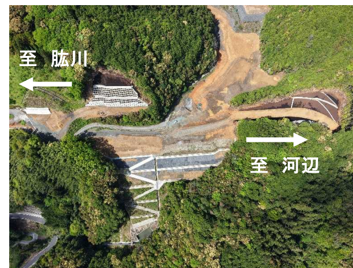
③敷水付替県道(令和8年4月)
