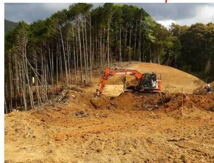
基礎掘削(左岸頂部)
