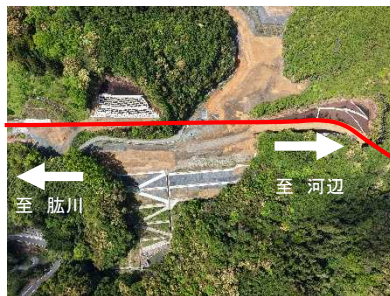
下敷水付替県道
