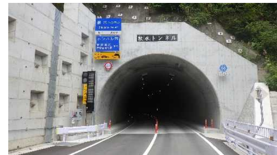
③敷水トンネル L=832m
