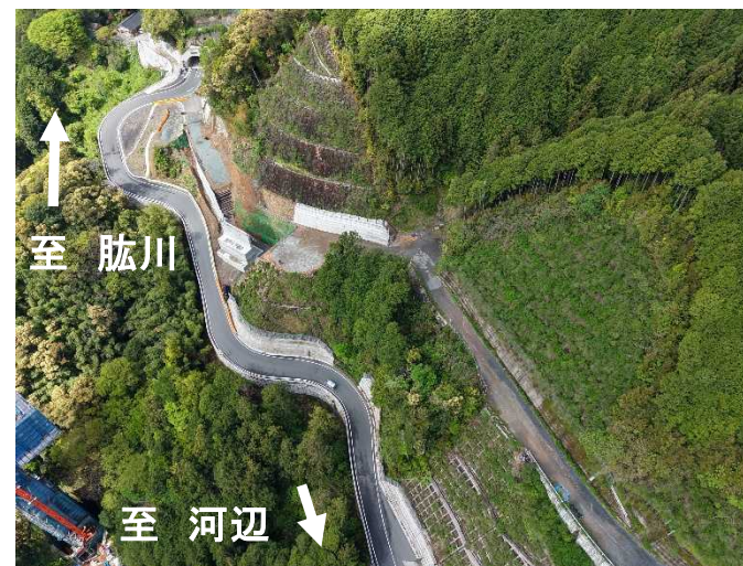
②下敷水付替県道(令和8年4月)
