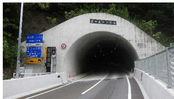
②愛の森トンネル L=2,128m
