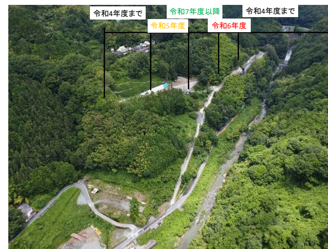
菟野尾地区付替県道 施工中(令和6年6月)
