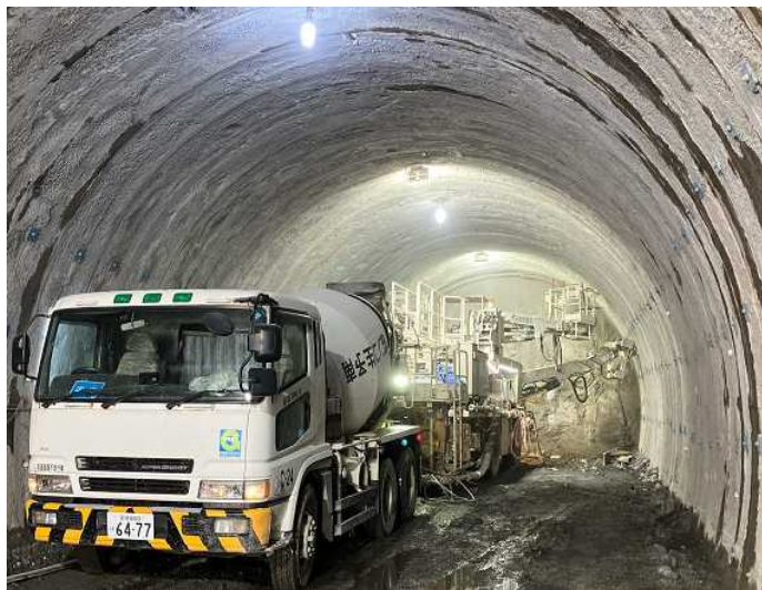
【吐口部】トンネル掘削状況(令和6年3月)
