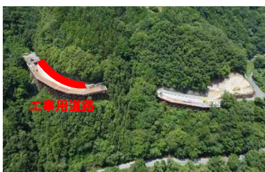
月野尾地区工事用道路
