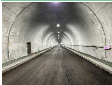
愛の森トンネル L=2,128m(R4.7.15貫通)
