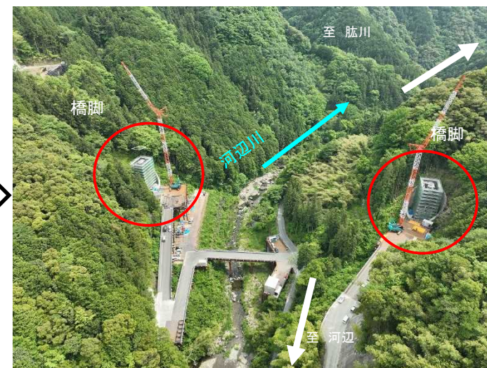
新入船橋橋脚 施工中(令和6年5月)
