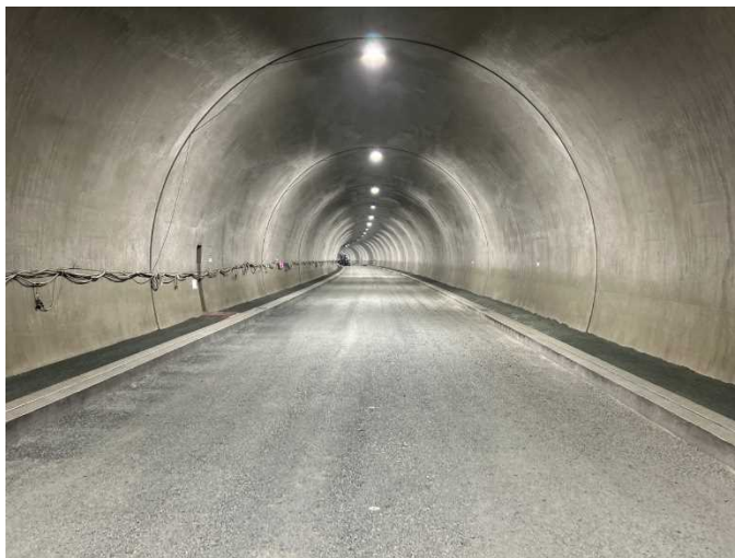
敷水トンネル 施工中(令和6年6月)
