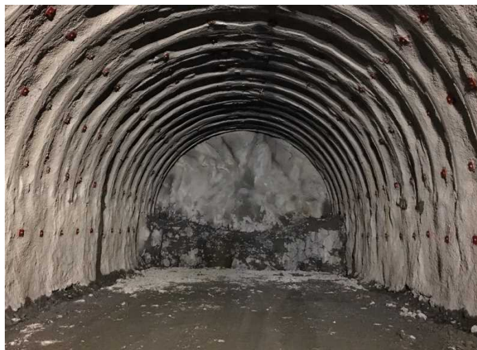
愛の森トンネル 施工中（令和3年3月）
