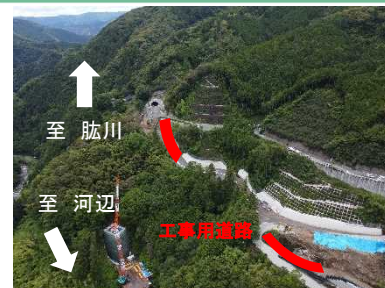
下敷水付替県道
