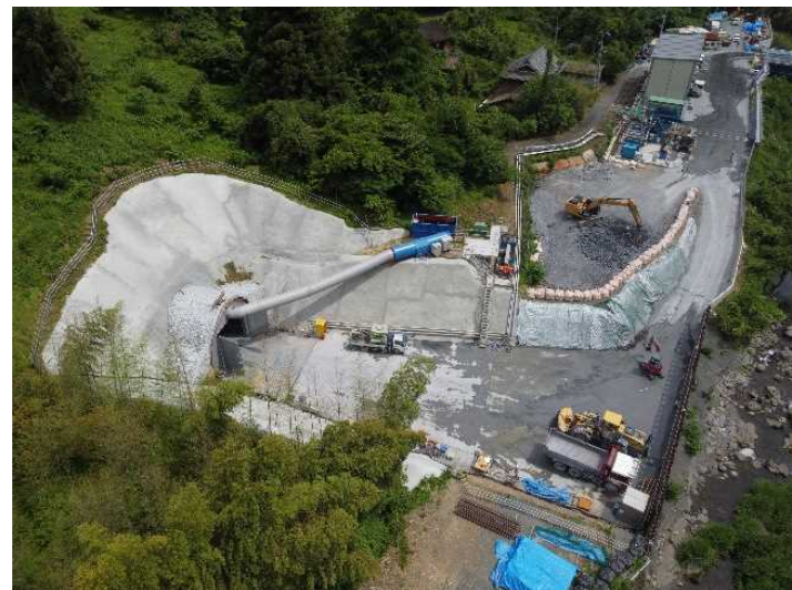
【吐口部】トンネル掘削状況(令和6年6月)
