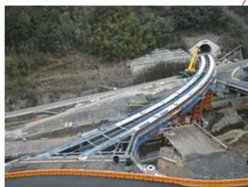
山鳥坂大橋上部
