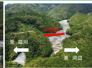
下敷水地区付替県道
