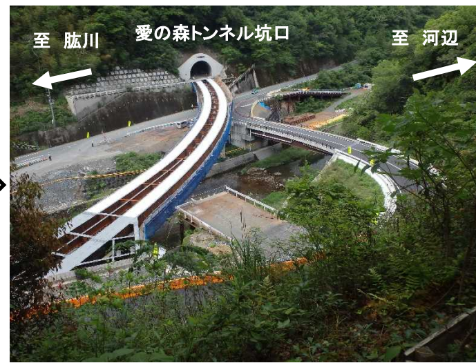
愛の森トンネル坑口（終点側） 施工中（令和6年6月）
