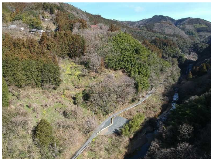
菟野尾地区付替県道 着手前(令和3年3月)
