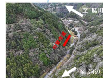
上嵯峨谷地区工付替市道
