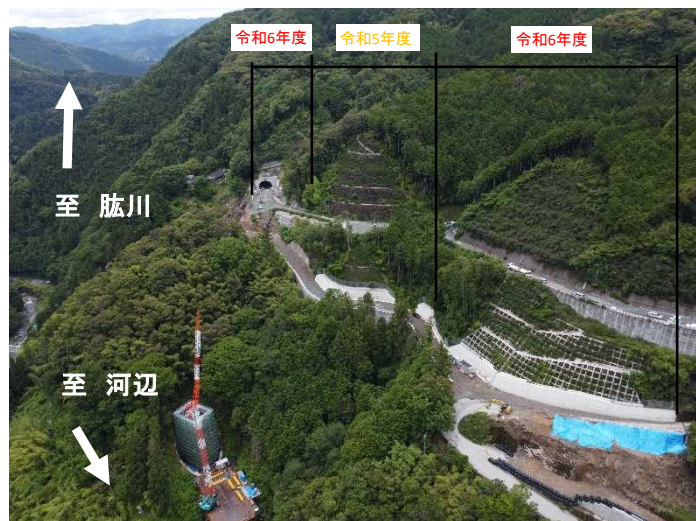
下敷水付替県道 施工中(令和6年6月)
