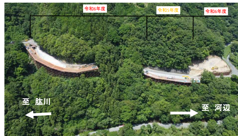
月野尾工事用道路 施工中(令和6年6月)
