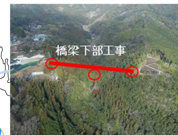
上敷水川橋下部
