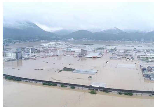
平成30年7月（梅雨前線）※大洲市提供
