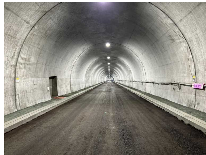
愛の森トンネル 施工中（令和6年6月）
