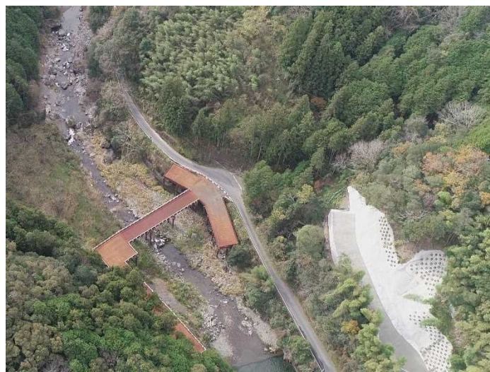
新入船橋作業構台 施工中(令和3年1月)
