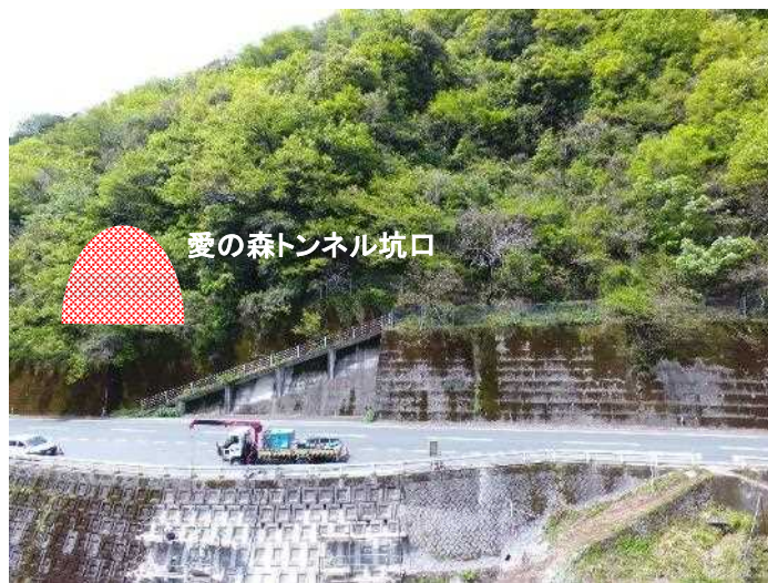
愛の森トンネル坑口（終点側） 着手前（平成29年4月）
