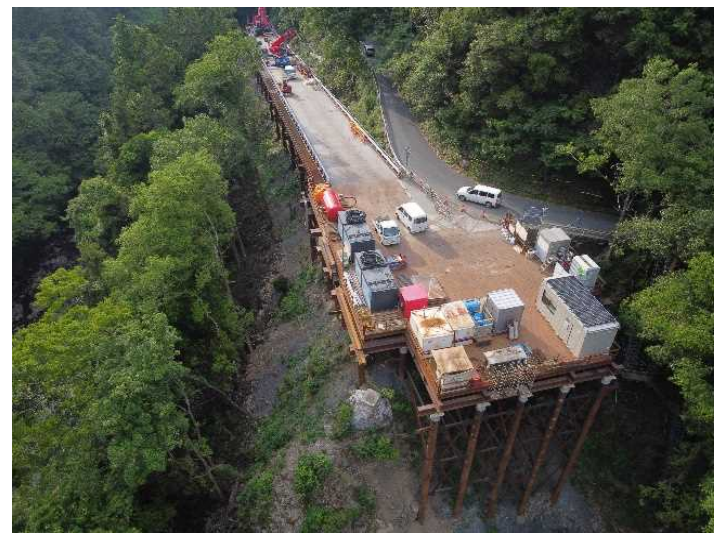
【呑口側】仮栈橋設置状況(令和6年6月)
