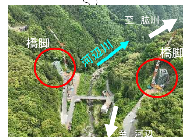
新入船橋橋脚
