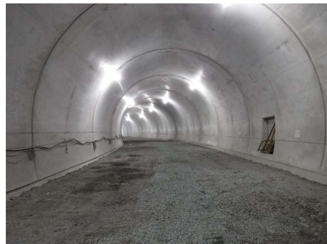
愛の森トンネル 施工中(令和5年4月)
