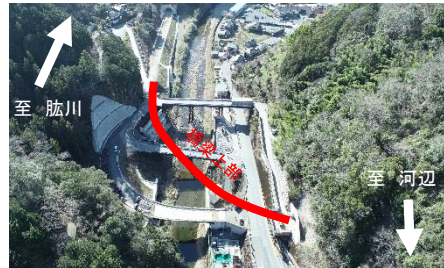
①橋梁上部
