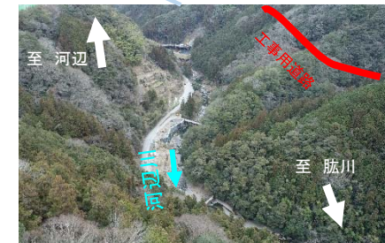
⑨下嵯峨谷地区工事用道路
