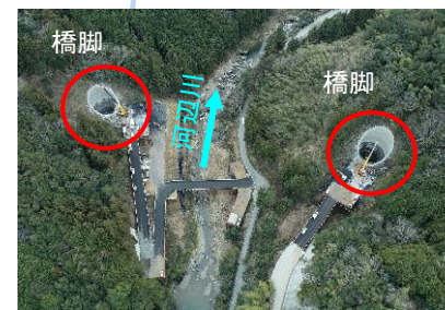
⑧新入船橋橋脚
