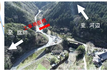
⑫新岩谷橋仮設構台
