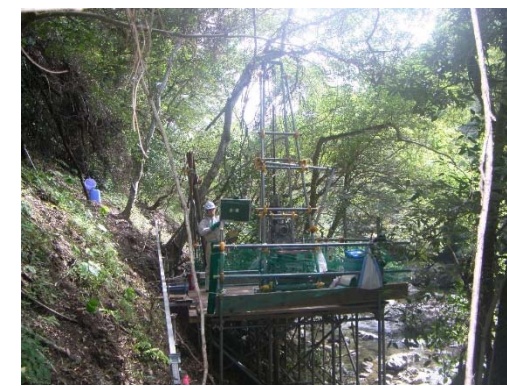
地質調査(ボーリング調査)
