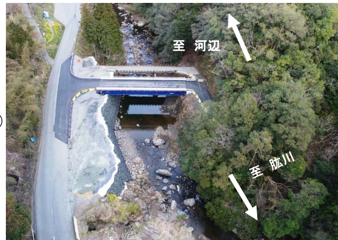
上嵯峨谷工事用道路 施工中(令和5年4月)
