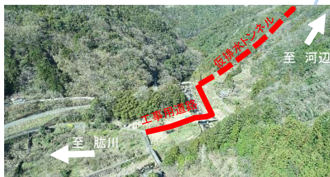
③京造地区工事用道路 仮排水トンネル
