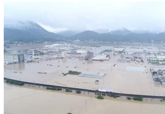
平成30年7月(梅雨前線)※大洲市提供
