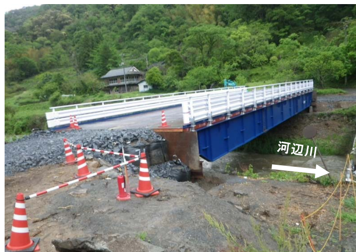
京造工事用道路 施工中(令和5年4月)
