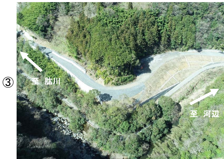
椽の木瀬地区付替県道 施工中(令和5年4月)
