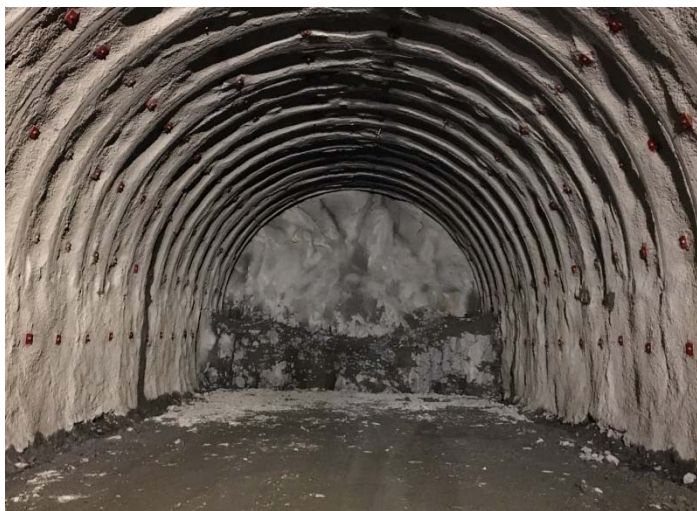
愛の森トンネル 施工中(令和3年3月)
