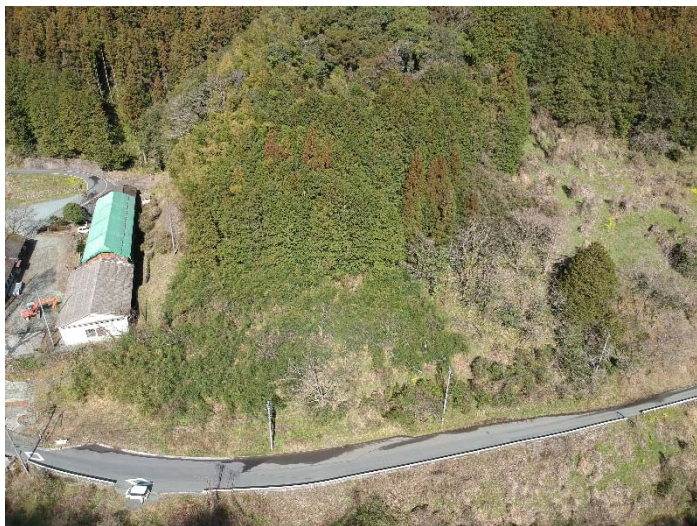
菟野尾地区付替県道 着手前(令和2年3月)
