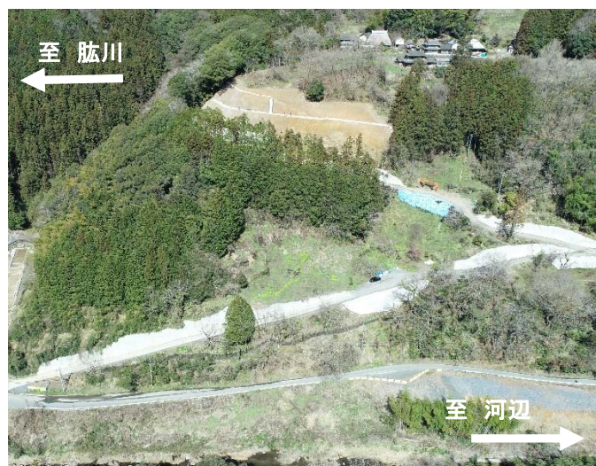
菟野尾地区付替県道 施工中(令和5年4月)
