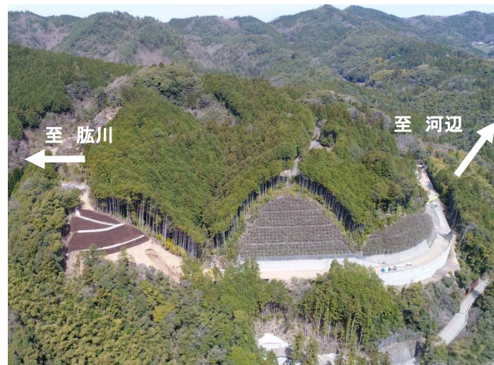
下敷水地区付替県道 着手後(令和元年6月)
