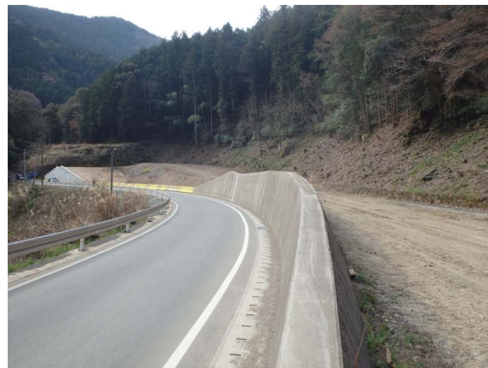
椋の木瀬地区付替県道 着手後(平成31年3月)
