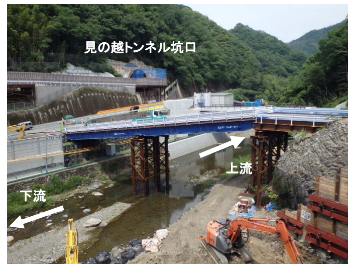
見の越トンネル坑口(終点側) 施工中(令和元年6月)
