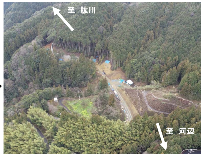
菟野尾地区付替県道 着手後(令和元年6月)
