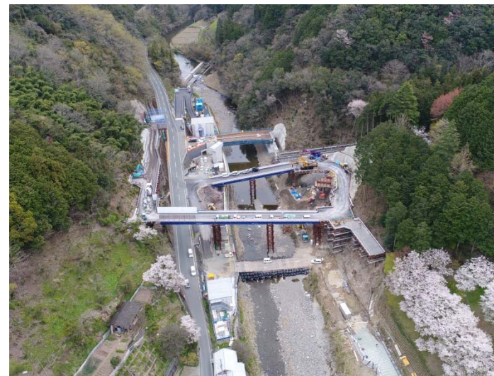
上鹿野川地区付替県道 施工中(令和元年6月)
