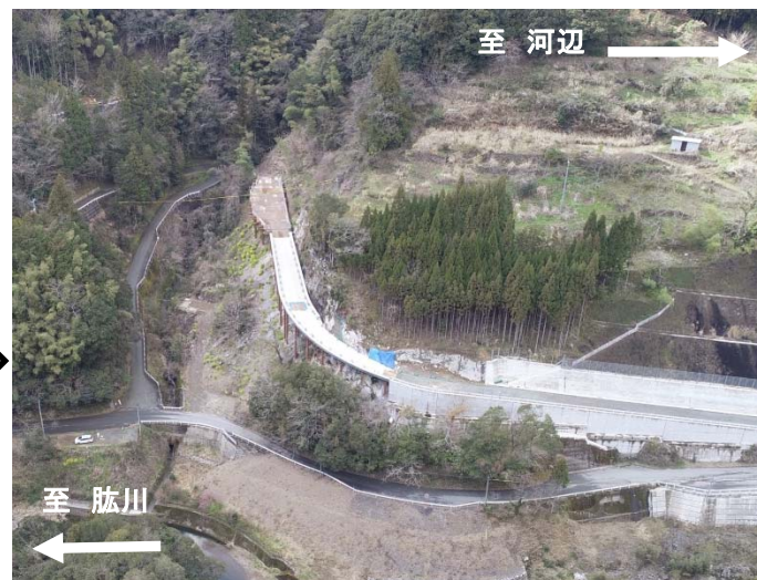
下敷水地区工事用道路 着手後(令和元年6月)
