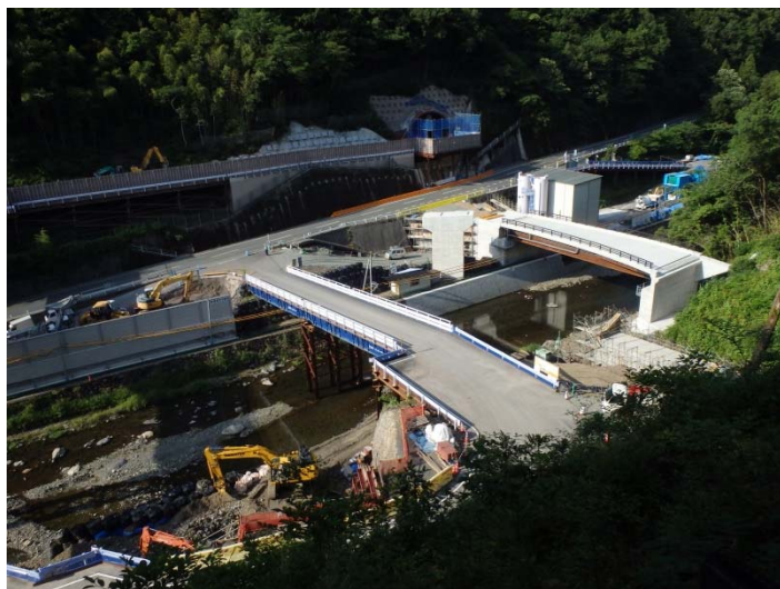
上鹿野川地区付替県道 施工中(令和元年6月)
