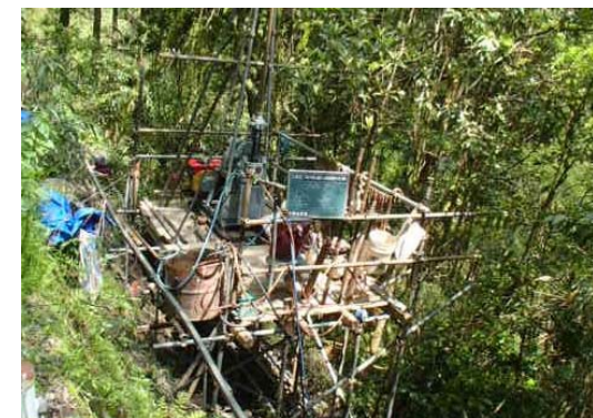
地質調査(ボーリング調査)
