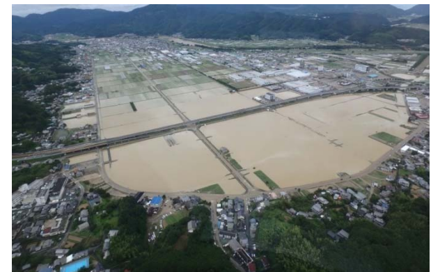
H30被害状況写真（東大洲地区）
