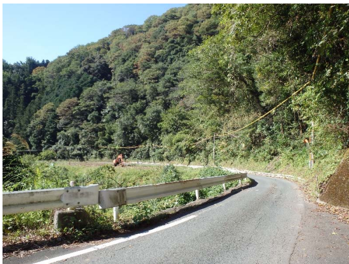
椋の木瀬地区付替県道 着手前(平成27年6月)
