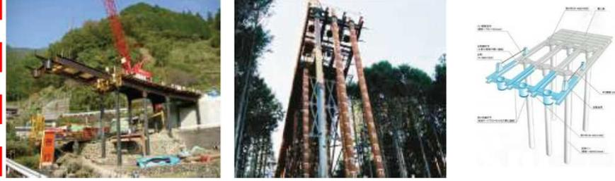
①パネルセット ⇒ ②削孔 ⇒ ③支持杭建込・根固打設 ⇒ ④上部工設置
