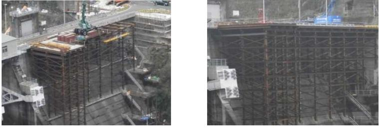
①導材設置 ⇒ ②削孔根固打設 ⇒ ③足場設置・杭頭処理 ⇒ ④プレス・水平材
