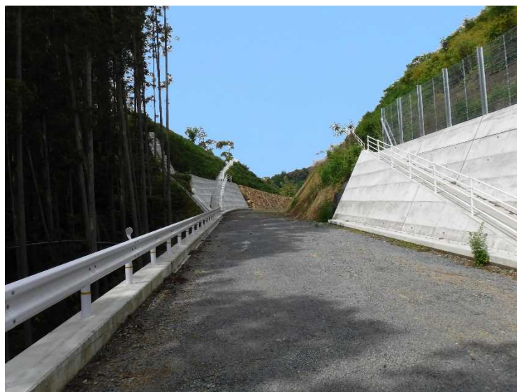
付替県道（菟野尾地区） R4. 6時点
