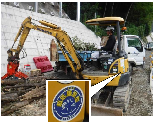
低騒音型建設機械の使用
