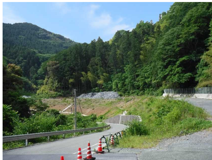
付替県道（椋の木瀬地区） R4. 6時点
