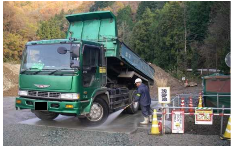
工事用車両のタイヤ洗浄
