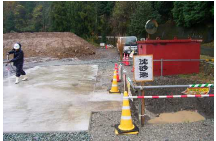
沈砂池の設置
