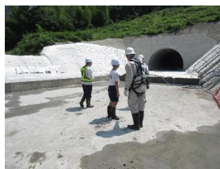
仮排水トンネル見学
