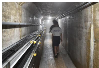
ダム監査廊見学
