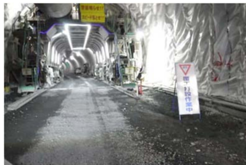
愛の森トンネル内部
