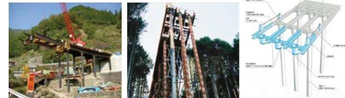
①パネルセット ⇒ ②削孔 ⇒ ③支持杭建込・根固打設 ⇒ ④上部工設置
