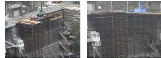
①導材設置 ⇒ ②削孔根固打設 ⇒ ③足場設置・杭頭処理 ⇒ ④プレス・水平材～上部工設置
