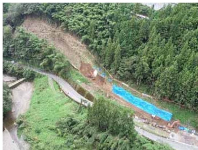
新入船橋工事用道路 施工中(令和元年10月)
