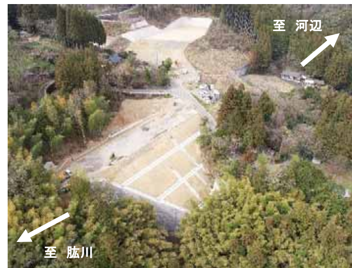
敷水地区付替県道 施工中(令和3年3月)
