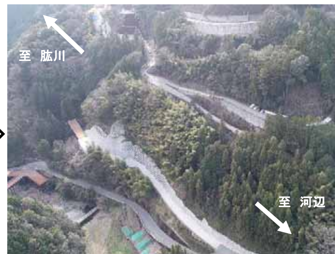
新入船橋工事用道路 施工中(令和3年3月)
