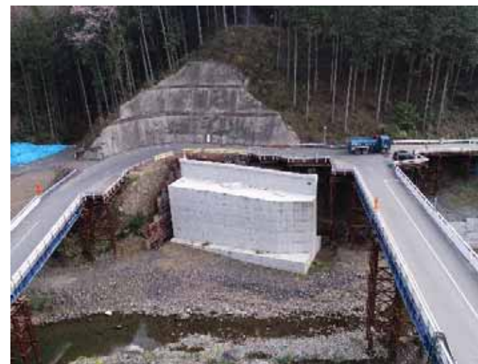
上鹿野川第1橋 施工中(令和3年3月)
