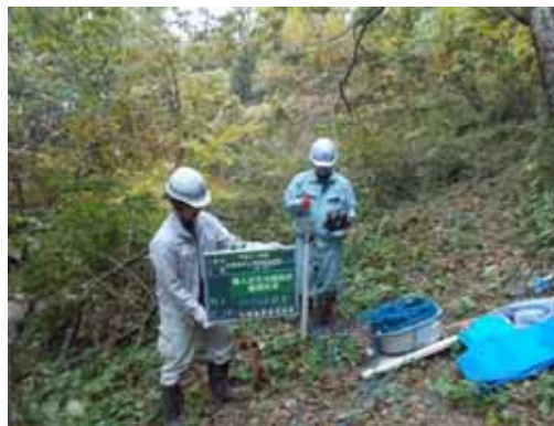
地すべり観測(孔内傾斜計観測状況)
