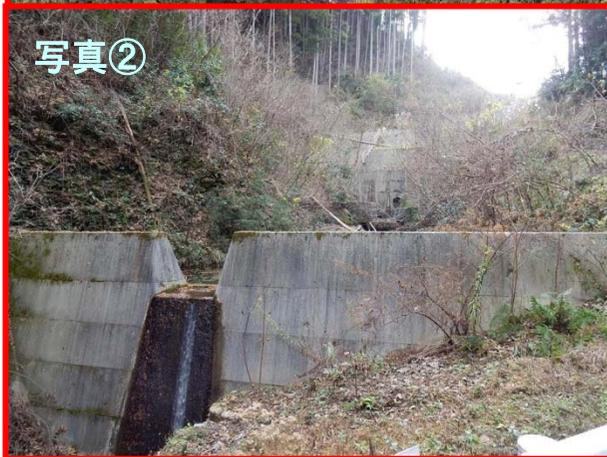
平成22年に設置した沈砂池により、降雨時に裸地から河川に流れる濁水を低減している。
