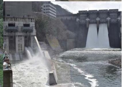
トンネル洪水吐が完成したことにより、従来より約 1.4 倍の洪水調節容量を確保することが可能になり、治水機能が增强されました。また、増加した洪水調節容量を活用し、野村ダムではより大規模洪水で、鹿野川ダムでは中規模洪水及びより大規模洪水で効果を発揮する操作規則に変更しました。
