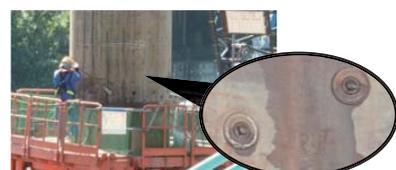
40m掘るために、ケーシングをボルトで縦につなげていきます。'つなげては掘って、外しては場所を移動'これを繰り返していきます。
