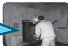
ダム上部からぶら下げられたステンレス線により、たわみ量を計測しています。
